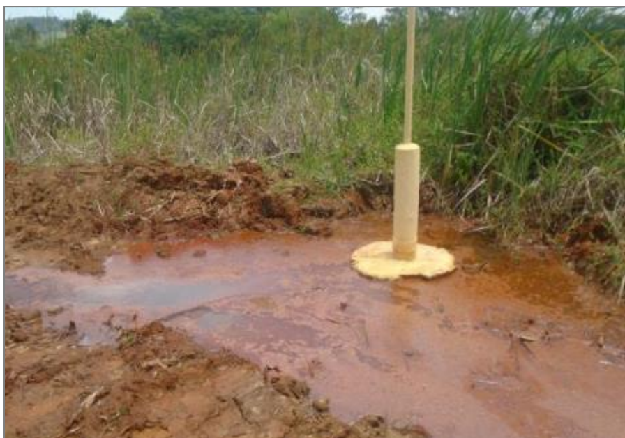
Figura 13 – furo de sonda que vertia DAM, após o tamponamento. É possível notar o alagamento do local, em função da nova surgência a 2 metros de distância. Retirado de SATC (2018).
