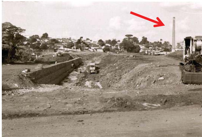
Figura 14. Obras de retificação do Córrego do Gregório, 1990, com a chaminé da Fábrica Facchina ao fundo (Foto obtida do acervo do Alemão).
