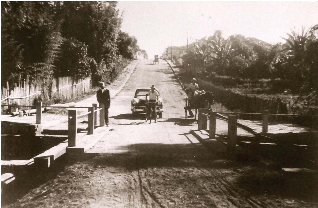
Figura 12. Ponte sobre o Rio Gregório, na rua São Paulo, conforme registro fotográfico de 1950. (Fonte: acervo do Alemão).
