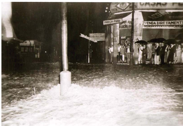
Figura 20. Pessoas ilhadas na Loja Casas Pernambucanas na Rua General Osório, no centro da cidade, durante um alagamento causado pela chuva em 1934. (Foto obtida do acervo do Alemão).
