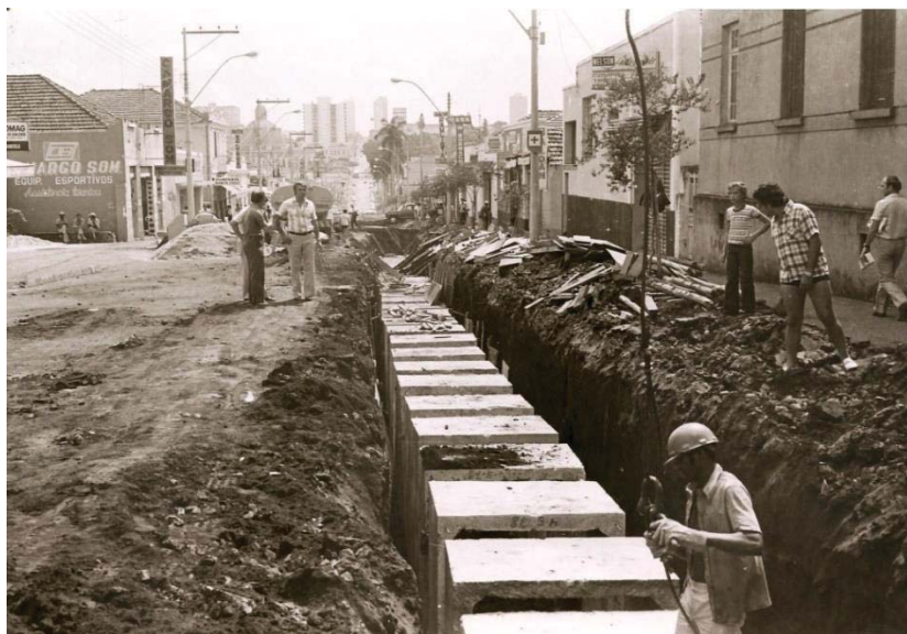
Figura 22. Construção de uma galeria na Avenida São Carlos em 1981. Ao fundo, a catedral e as palmeiras do Largo Santa Cruz (Foto obtida do acervo do Alemão).
