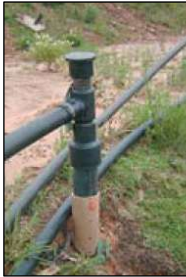
Figura 11: Cabeçote de adaptação de dreno existente, modelo nacional Fonte: ICLEI, 2009
