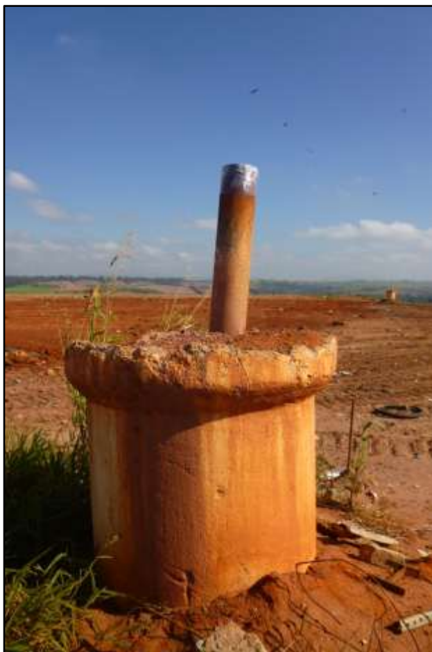
Figura 10: Dreno típico de gases de aterro sanitário, presente na unidade de Rio Claro/SP
