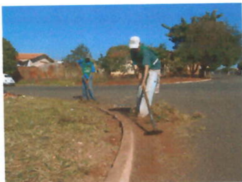
Foto 11-2 – Manutenção de sarjetas
