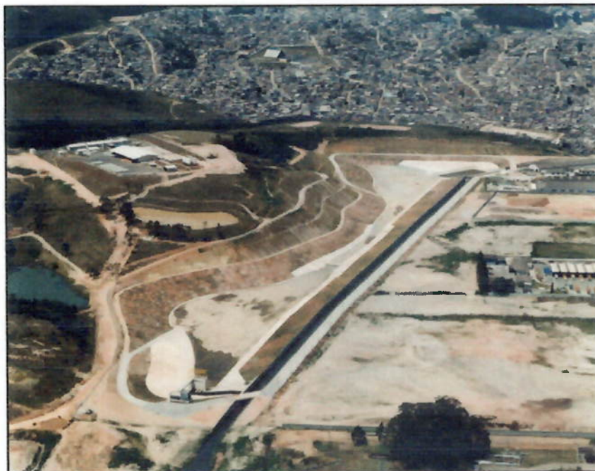
Foto 3-6 - Piscinão de Capuava em fase de construção – Arquivo do DAEE / 2002
