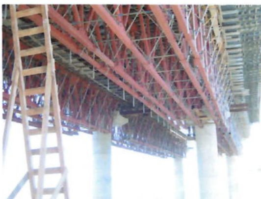
Foto 9-3 – Detalhe das Trelças e Fôrmas
