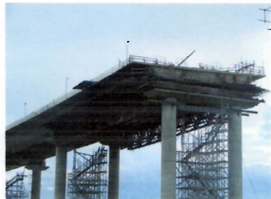
Foto 9-1 – Cimbramento Móvel com Trelças Metálicas
