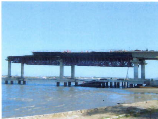
Foto 9-1 – Cimbramento Móvel com Trelças Metálicas
