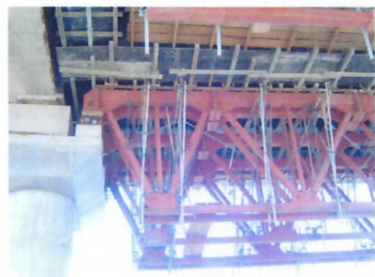
Foto 9-3 – Detalhe das Trelças e Fôrmas
