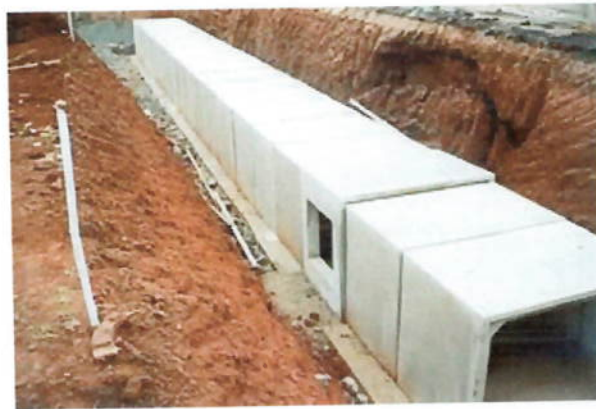
Foto 11-7 – Execução de galerias celulares.
