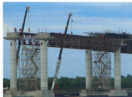
Foto 9-2 – Execução em Trecho de Ponte Curva em Planta
