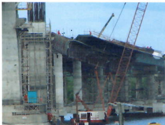
Foto 9-2 – Execução em Trecho de Ponte Curva em Planta
