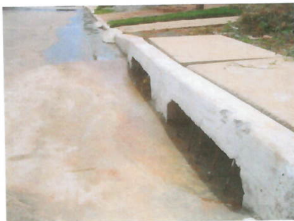
Foto 11-4 – Boca de lobo colocada para limitar a lâmina d'água.
