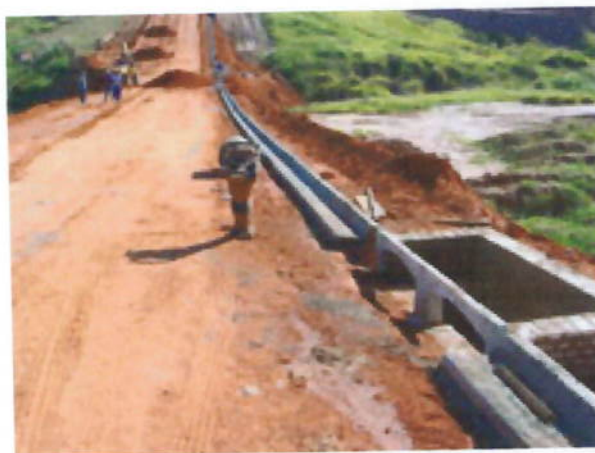
Foto 11-6 – Execução da sarjeta e boca de lobo
