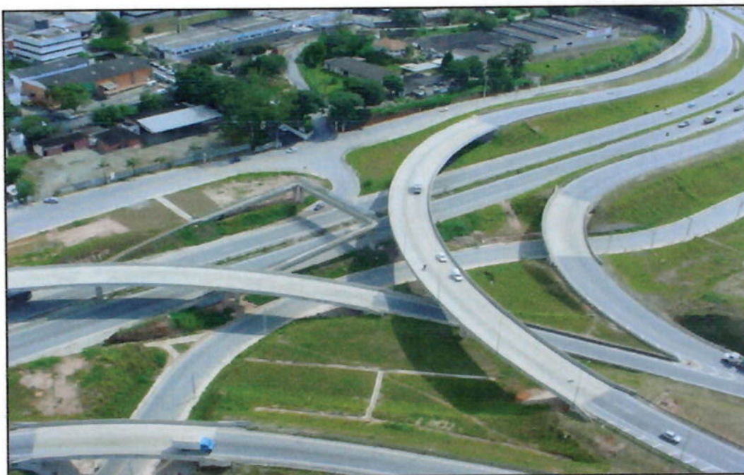
Foto 3-3 - Trecho Oeste já concluído
