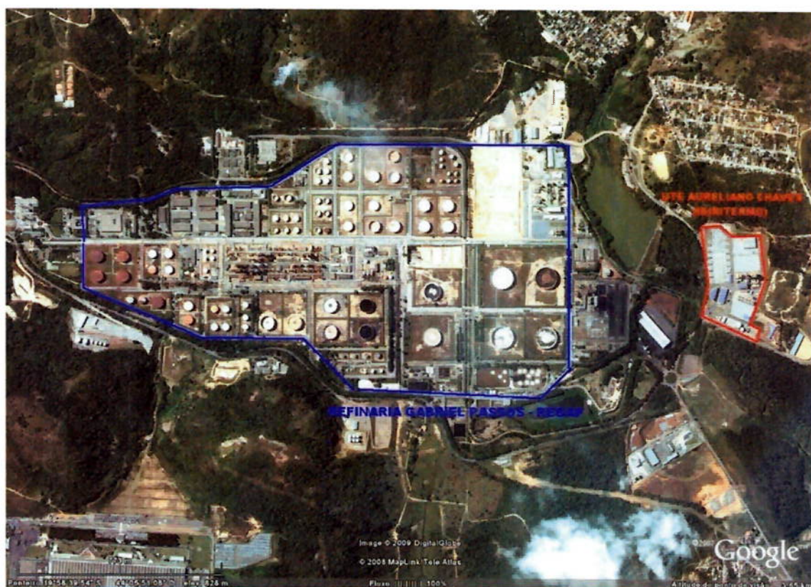
Figura 5.2 - Localização da termelétrica Aureliano Chaves [38]
