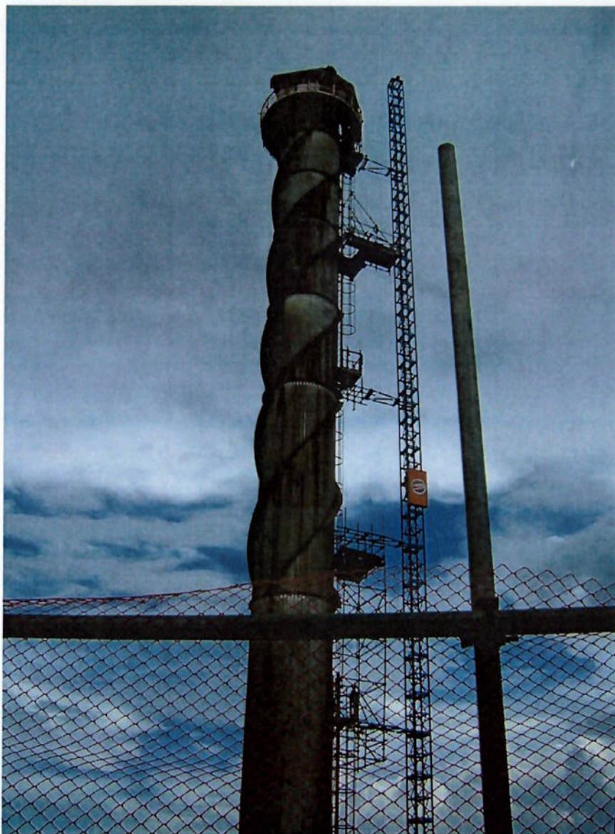
Figura 8 – Desmontagem de elevador, em fase de Pós-Parada.
