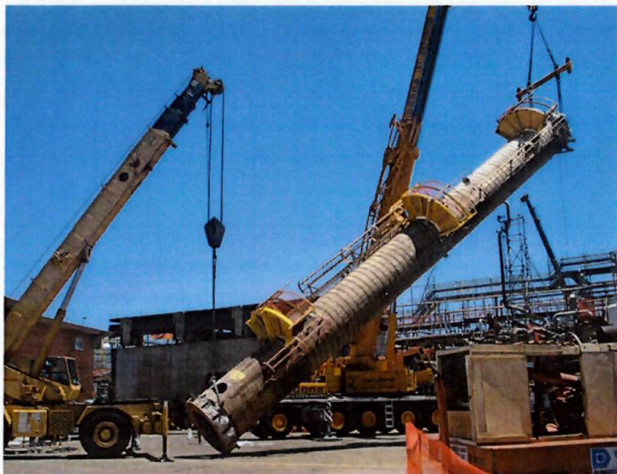
Figura 7 – Movimentação de cargas, em parada de manutenção.
