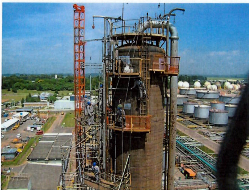
Figura 6 – Equipe executando montagem de andaime em Pré-Parada.
