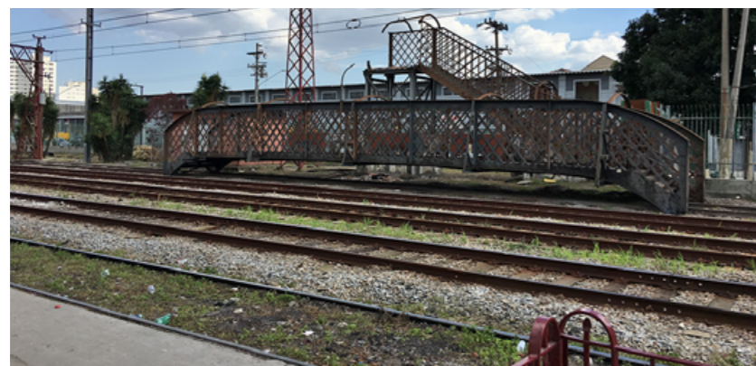
Figura 5. Fotografia da passarela depois de ser removida. Fonte: http://www.saopauloantiga.com.br/passarela-da-rua-visconde-de-parnaiba-sera-restaurada/ . São Paulo, abril de 2017
