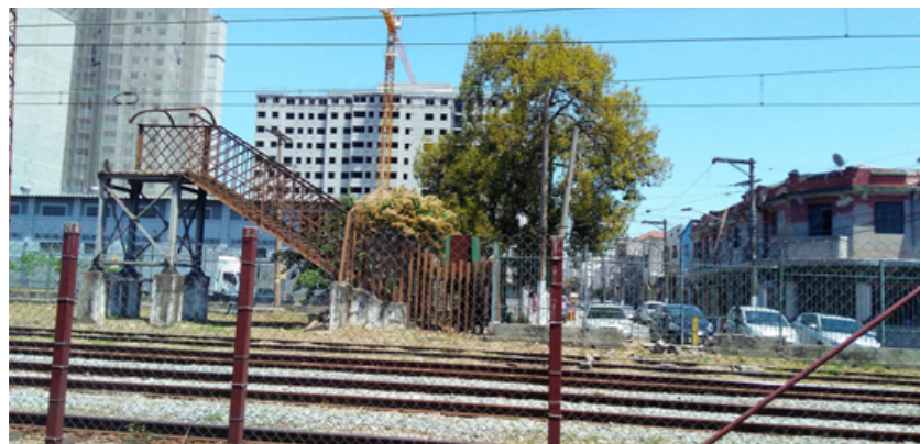
Figura 6. Fotografia da passarela depois de ter sido removida. Fonte: Autoria própria. São Paulo, outubro de 2019
