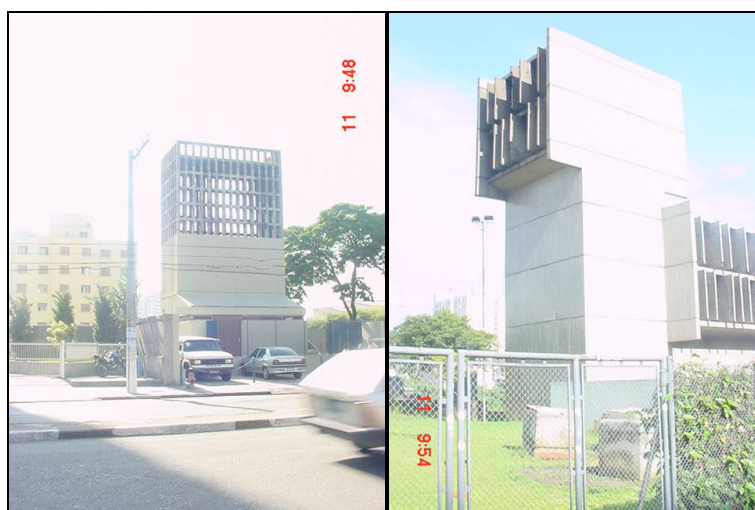
Figura 11 - Torres de Poços de Ventilação (METRÔ, 2009a)
