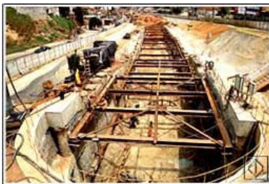
Figura 3 - VCA no emboque do Túnel Tucuruvi (METRÔ, 2009a).
