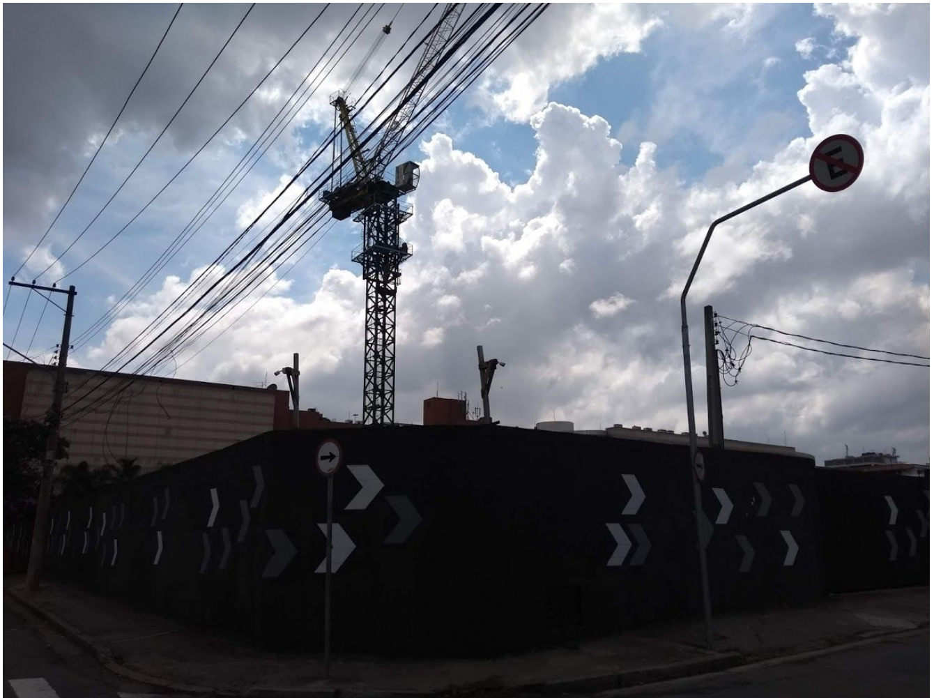
Foto 5: Edifício Platina 220 em fase de construção, maio de 2019. | Fonte: Lucas Vannucchi Leme Ramalho
