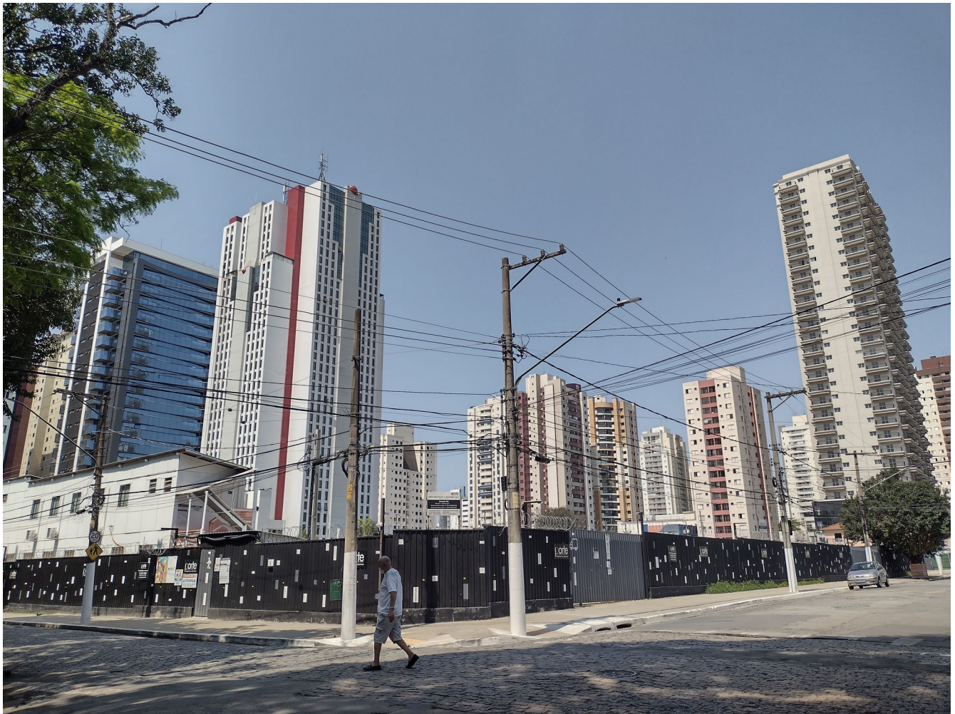
Foto 7: Local aonde estava a Vila João Migliari e aonde será construído o prédio Almagah. | Fonte: Lucas Vannucchi Leme Ramalho
