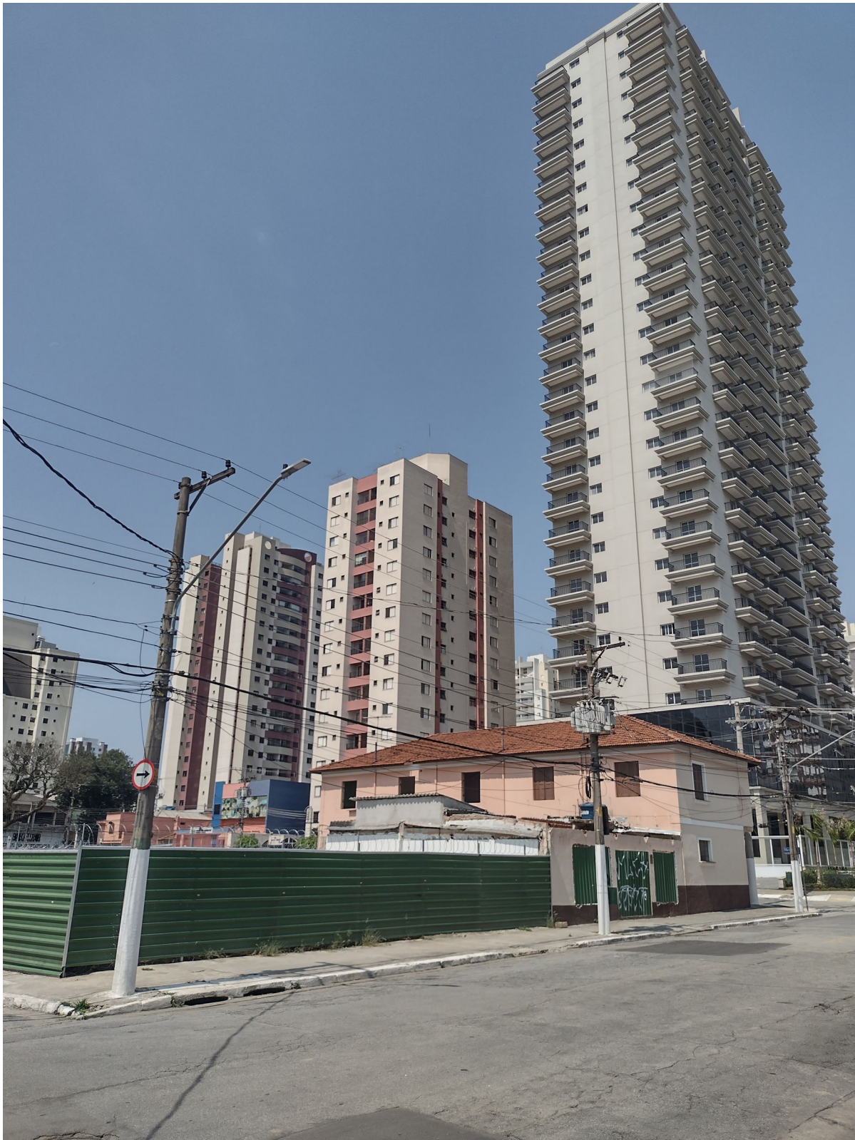
Foto 8: Tapume tampando as ruínas das 55 casas demolidas e as cinco casas que sobraram da Vila João Migliari ao fundo em setembro de 2021, todas sem uso e moradores. | Fonte: Lucas Vannucchi Leme Ramalho
