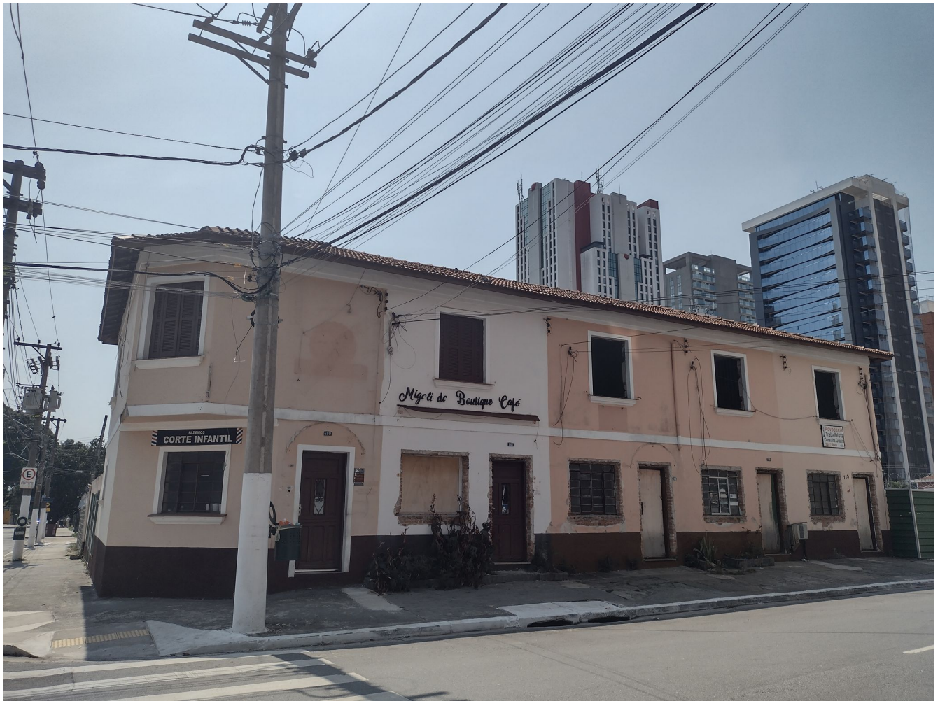
Foto 9: As 5 casas que sobraram depois da destruição em setembro de 2021. | Fonte: Lucas Vannucchi Leme Ramalho.
