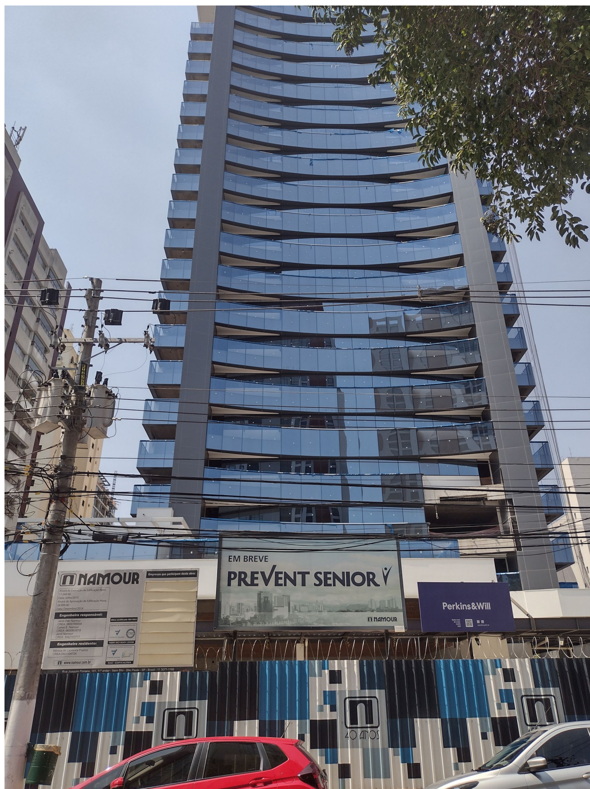
Foto 10: Prédio em construção da Prevent Senior logo na frente do terreno em que será construído o Almagah. | Fonte: Lucas Vannucchi Leme Ramalho
