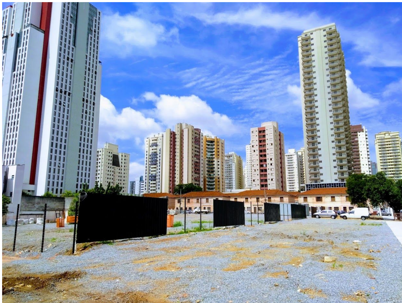
Foto 1: área estabelecida para a construção do empreendimento Almagah com a Vila João Migliari ao fundo meses antes da demolição | Fonte: Lucas Vannucchi Leme Ramalho
