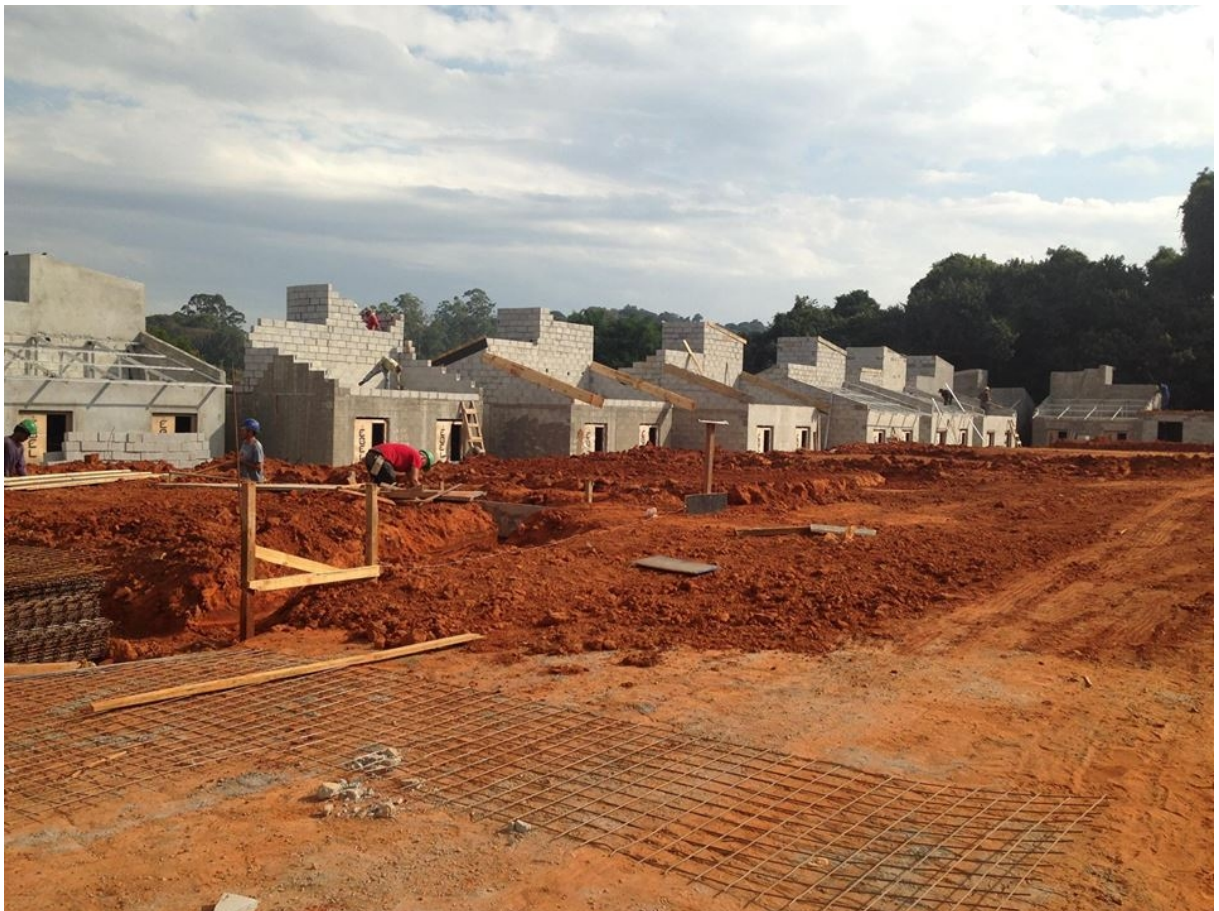
Construção do conjunto residencial Zorilda Maria dos Santos | Acervo de imagens da CEMOS.
