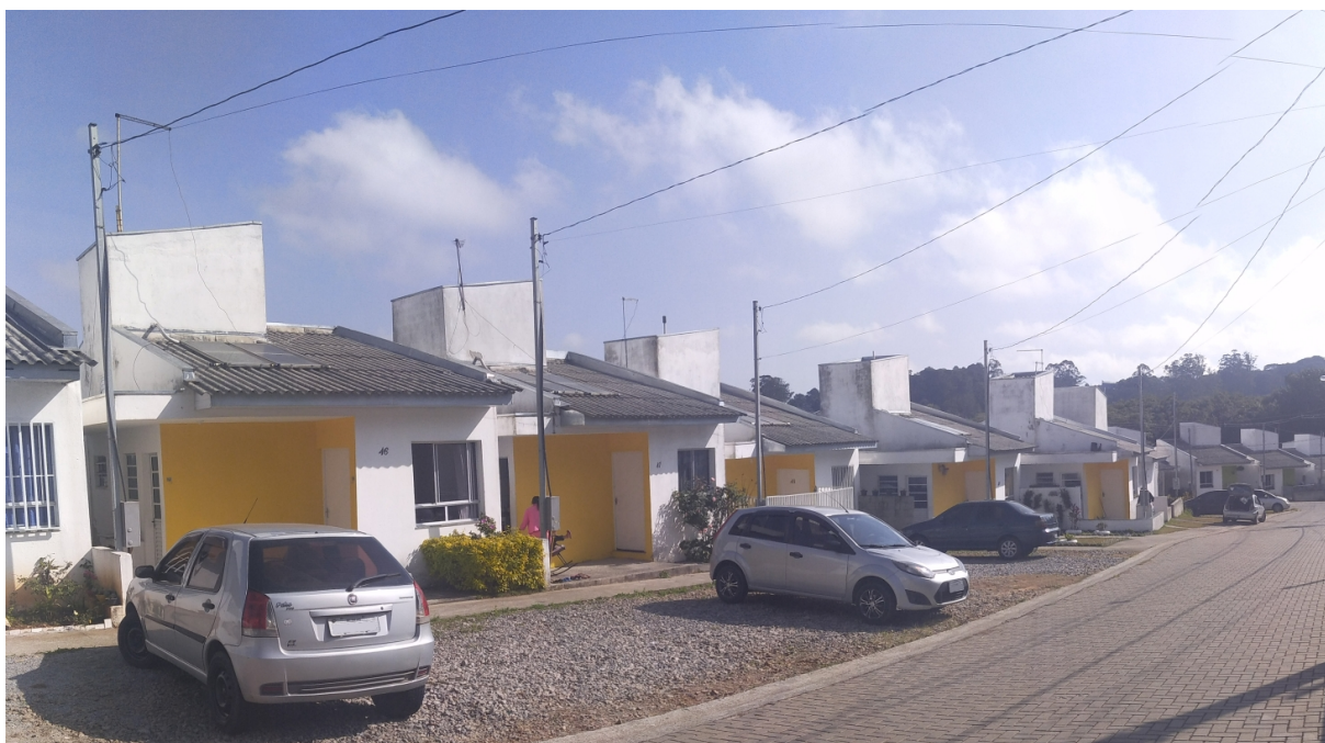
Figura 14: Entrada ao conjunto residencial atualmente (agosto de 2019). Acervo pessoal.
