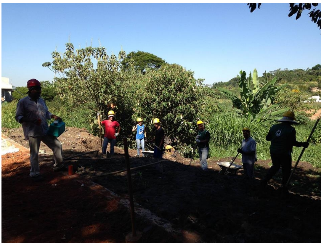
Figura 10: Obras de limpeza e nivelamento em parcelas do terreno do Zorilda. Fonte: página do facebook da CEMOS.
