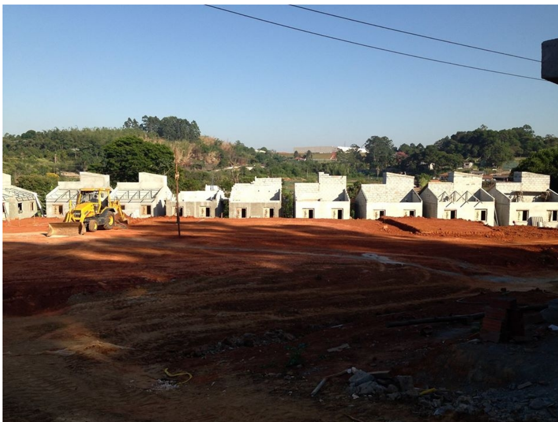
Figura 11: Obras em andamento. Fonte: página do facebook da CEMOS.
