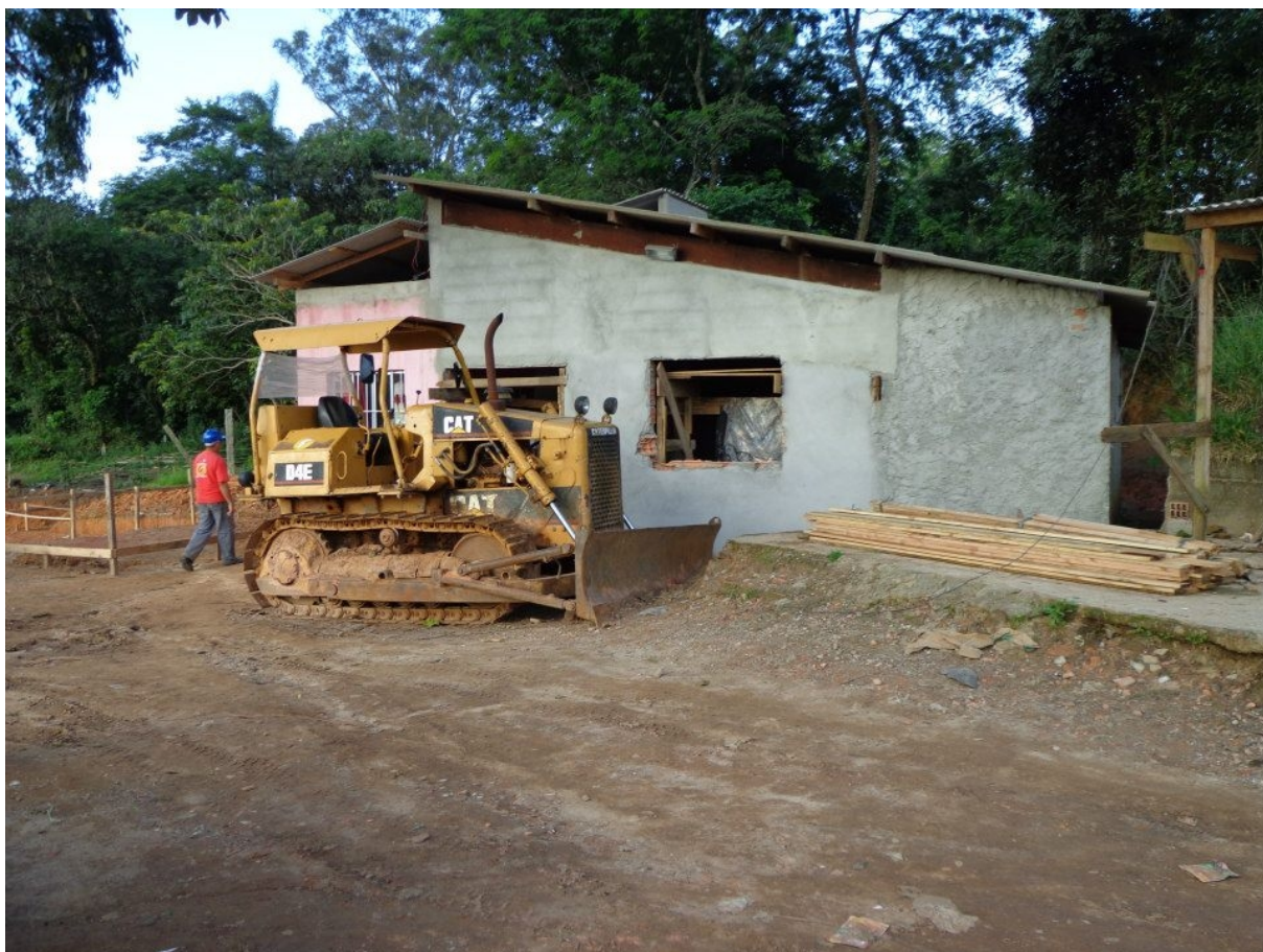
Figura 8: Ainda no início das obras no terreno de implantação do conjunto Residencial Zorilda Maria dos Santos. Fonte: página do facebook da CEMOS.
