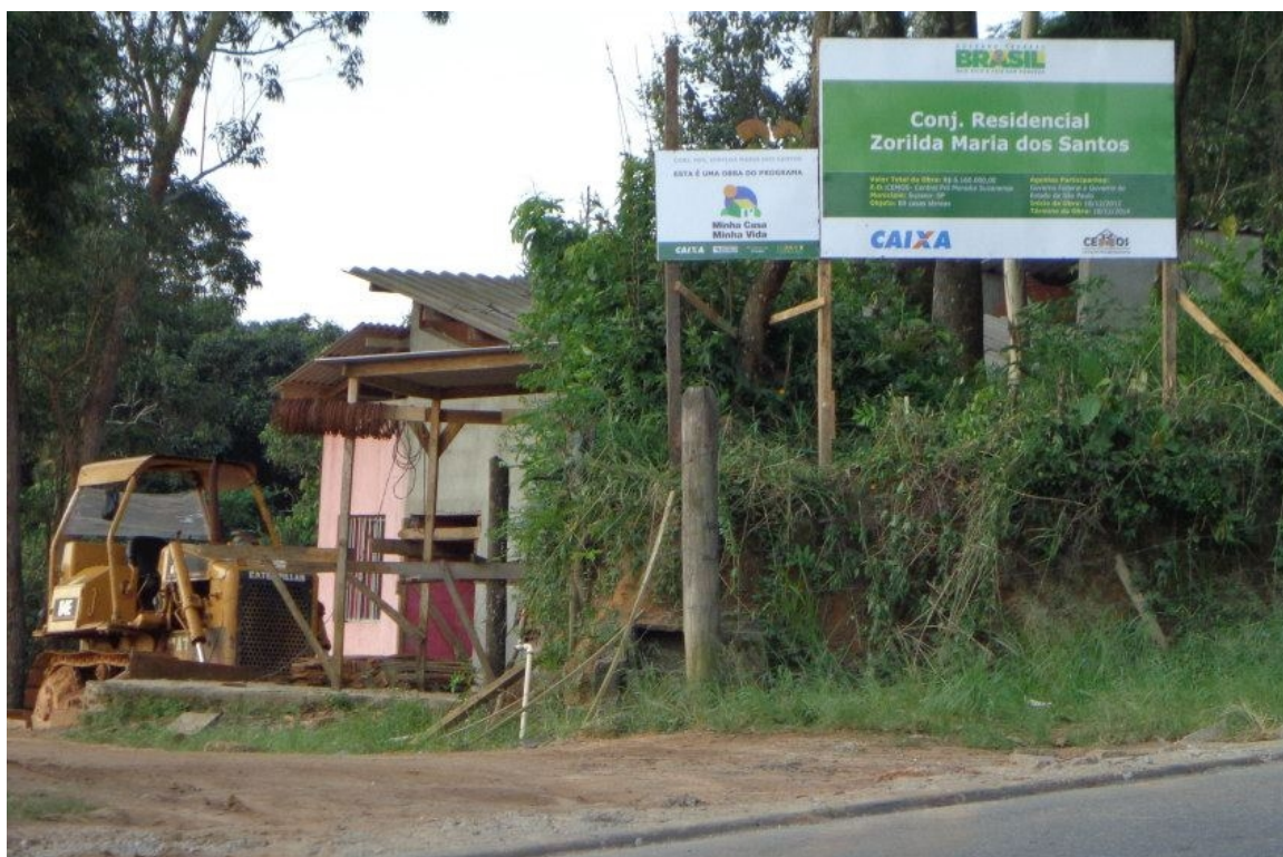
Figura 9: Entrada para o lote no início das obras. Fonte: página do facebook da CEMOS.
