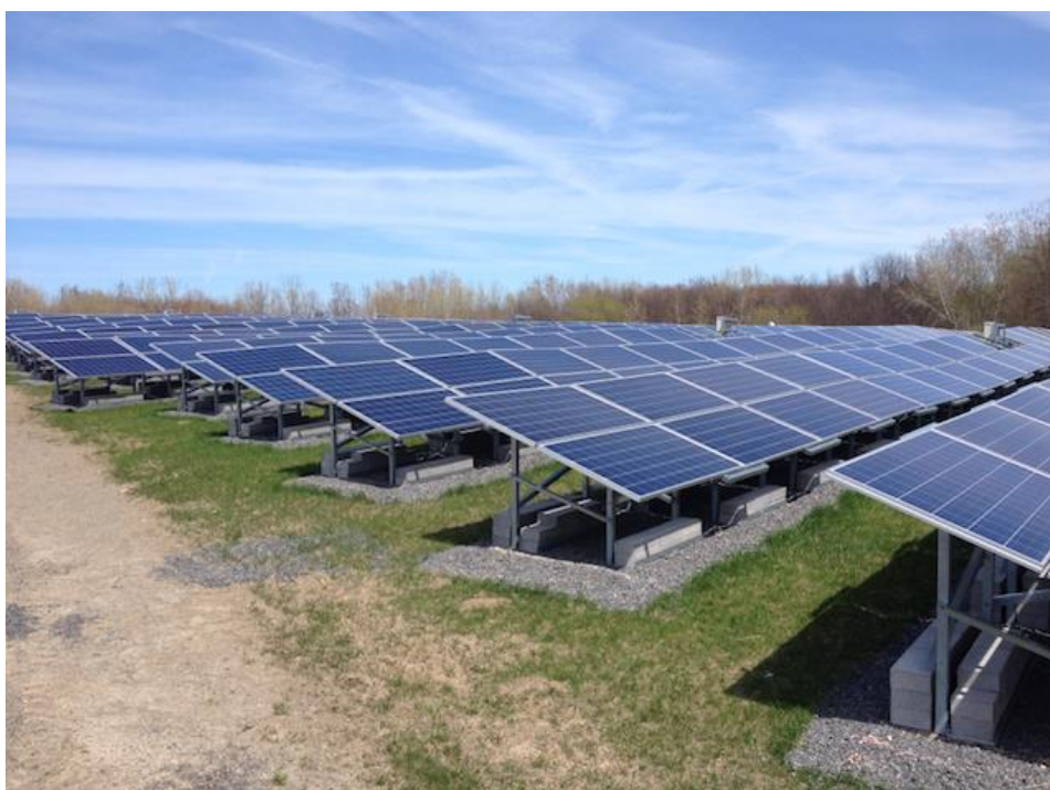
Figura 19. Exemplo de instalação fotovoltaica no solo
