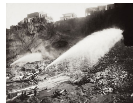
Demolição hidráulica do Morro do Castelo, Rio de Janeiro. A obra foi determinada pelo prefeito Carlos Sampaio em 1921 e, segundo o governo, se justificava pela necessidade de higienização e modernização da cidade.
