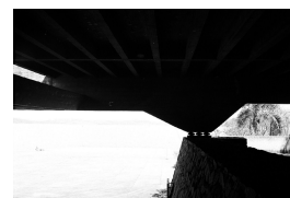
(Garagem de Barcos) Detalhe do encontro da cobertura com a fundação através das rótulas metálicas. Autor desconhecido
