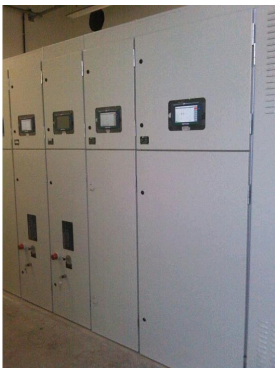
Figura 19: UPD'S Sepcos Instalados nos Cubículos de Tração ref. projeto executivo Vlt Santos
