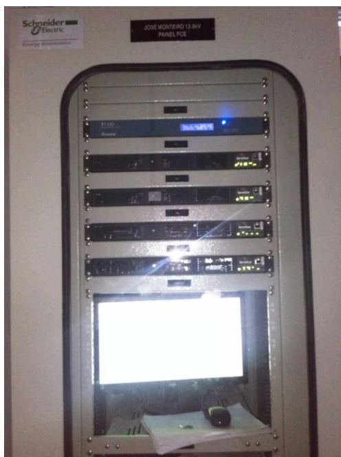
Figura 22: Rack com sistema supervisório na subestação ref. fornecimento Vlt Santos
