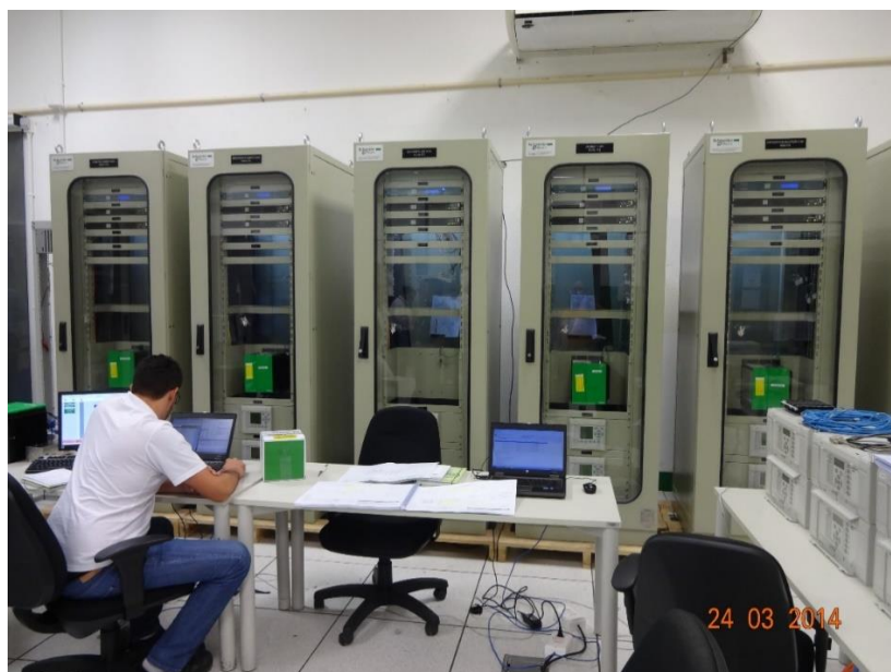
Figura 18: Rack Paineis de comando controle e Proteção (PCE) ref. Projeto Executivo Vlt Santos
