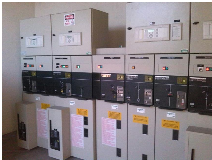
Figura 20: UPD'S Micom Instalados nos Cubículos de Media tensão ref. Projeto Executivo Vlt Santos
