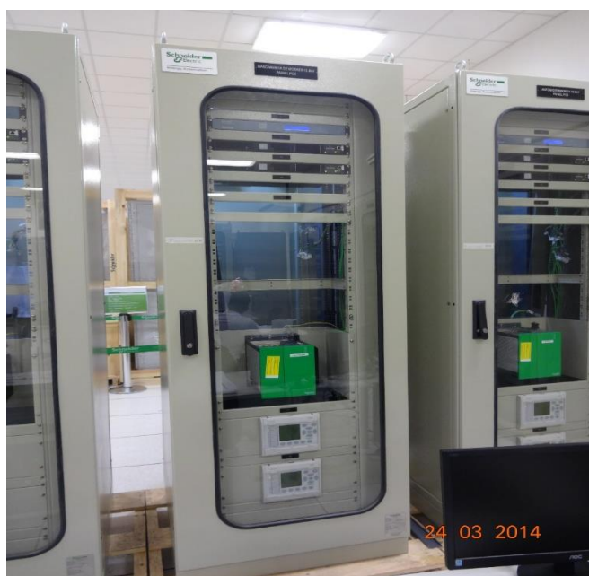
Figura 17: Rack Painel de comando controle e Proteção (PCE) ref. Projeto Executivo Vlt Santos
