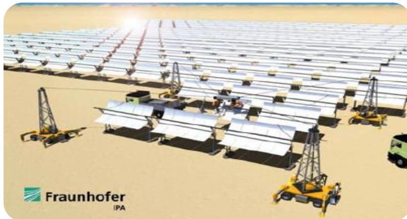
Figura 6 - Conceito de montagem de painéis solares através do uso de CDPRs
