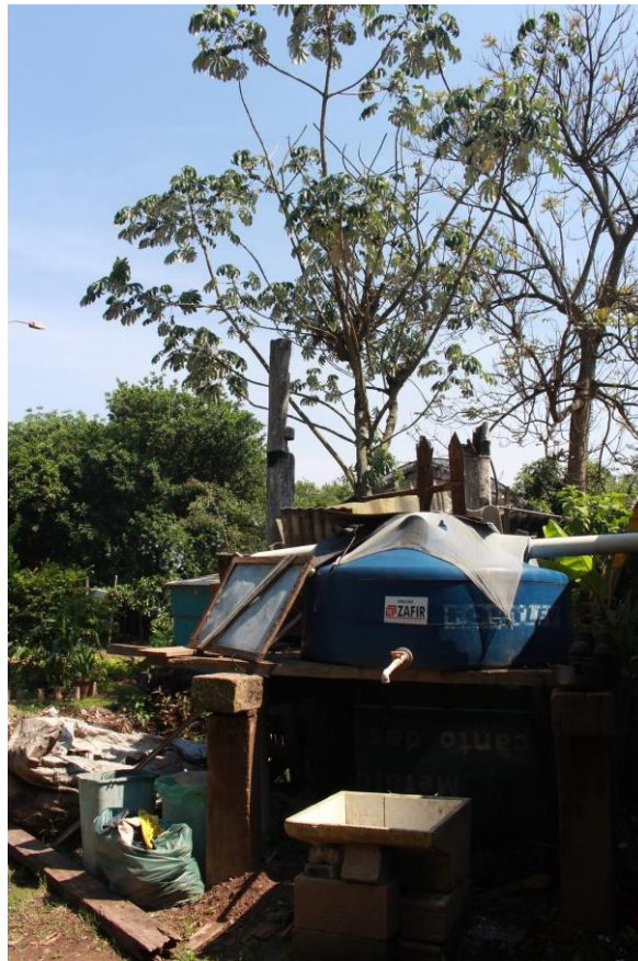
Figura 5 - Captação de água da chuva
