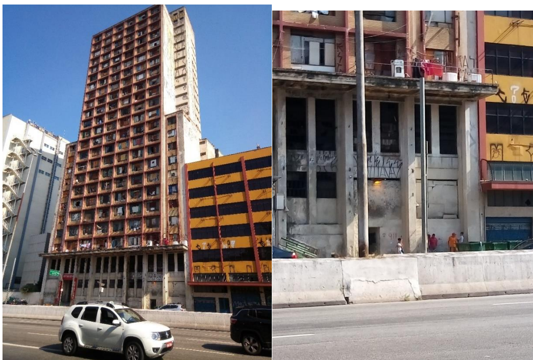
Figuras 4 e 5: Fachada da Ocupação Prestes Maia
