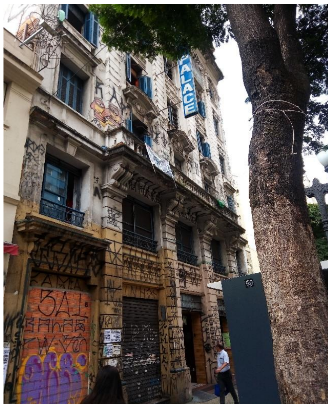
Figura 6: Fachada da Ocupação São João.
