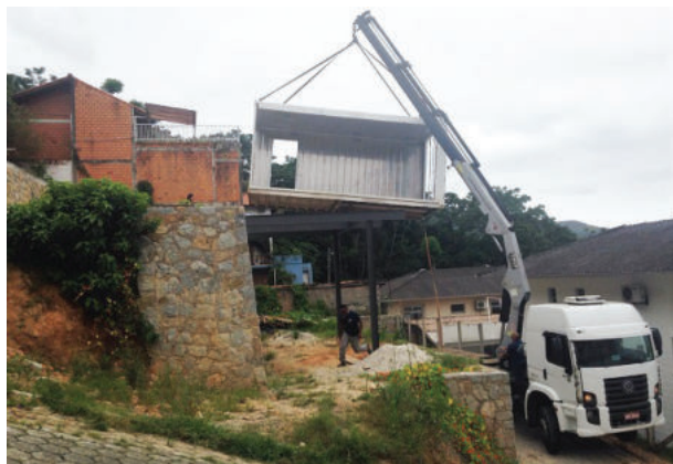
Figura 42. CASE 1 - Movimentação de contêiner com a utilização de caminhão Munck. A estrutura de sustentação do contêiner foi feita em vigas metálicas.
