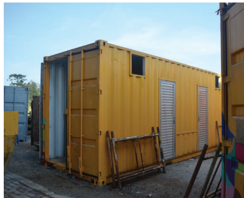
Figura 136. Tubos de Metalon nas aberturas onde são instalados os caixilhos
