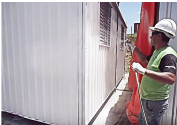
Figura 37. Aplicação de Tinta Térmica.
