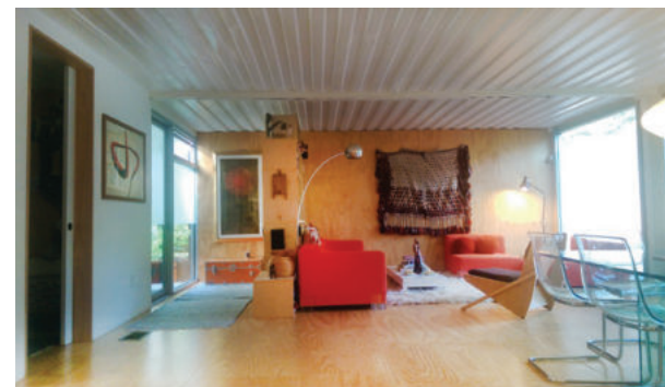
Figura 73. CASE 5 - Interior da ampliação em contêineres. Teto do contêiner aparente e paredes revestidas em placas de madeira. Amplas janelas de vidro. Fonte: < http://www.studiojantzen.com/ >
