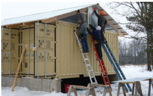
Figura 39 e 40. Instalação de cobertura adicional.
