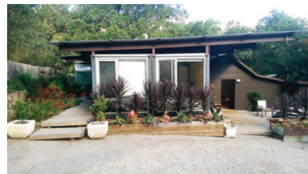
Figura 72. CASE 5 - Telhado de metal corrugado "flutuando" sobre os contêineres e sobre a residência original em madeira. Fonte: < http://www.studiojantzen.com/ >
