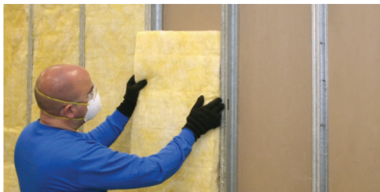
Figura 133. Instalação da Lã de Vidro na parede de Drywall
