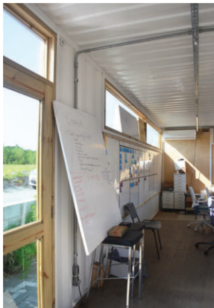
Figura 38. Ausência de revestimentos internos em uma das salas da Fábrica Contain[it].
