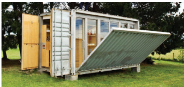
Figura 52. CASE 2 - Possibilidade de fechamento da lateral do contêiner e das portas, para transporte Fonte: < http://www.containersa.com.br/ >
