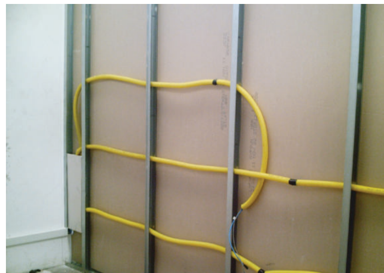
Figura 132. Parede Drywall mostrando as instalações internas
