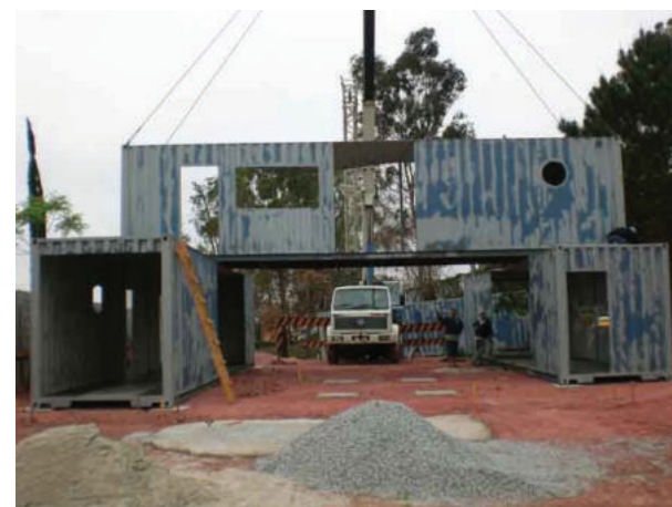
Figura 45. CASE 4 - Casa Contêiner Granja Vianna - Posicionamento dos contêineres no terreno com auxílio de um caminhão Munck.
