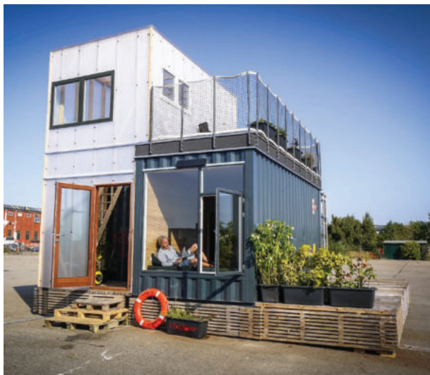
Figura 74. CASE 6 - Protótipo da moradia estudantil em contêiner, instalado sobre um deck, sem a necessidade de fundação. Fonte: CPH Container
