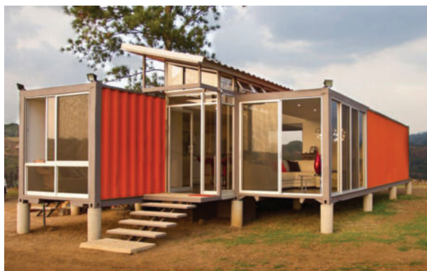
Figura 32. Fundação em Sapata Isolada, mais comum em construções em contêineres. Nesse caso, os contêineres são sustentados por pilares que, por sua vez são sustentados pelas sapatas. Fonte: Casa e Decoração
