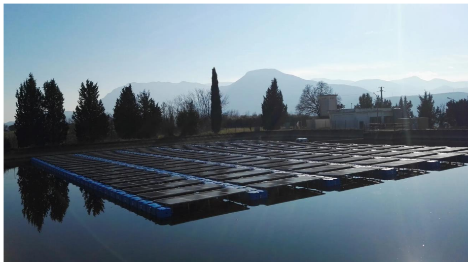
Figura 11 - Painéis fotovoltaicos flutuantes
