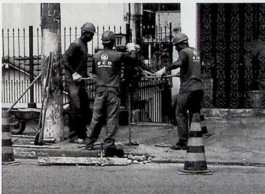
Perfurações realizadas PM-8.
