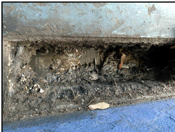
Figura 19 – Ralo de escoamento para rede de esgoto cheio de resíduo oleoso
