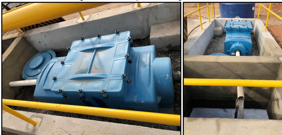
Figura 14 – Caixa separadora de água e óleo.
