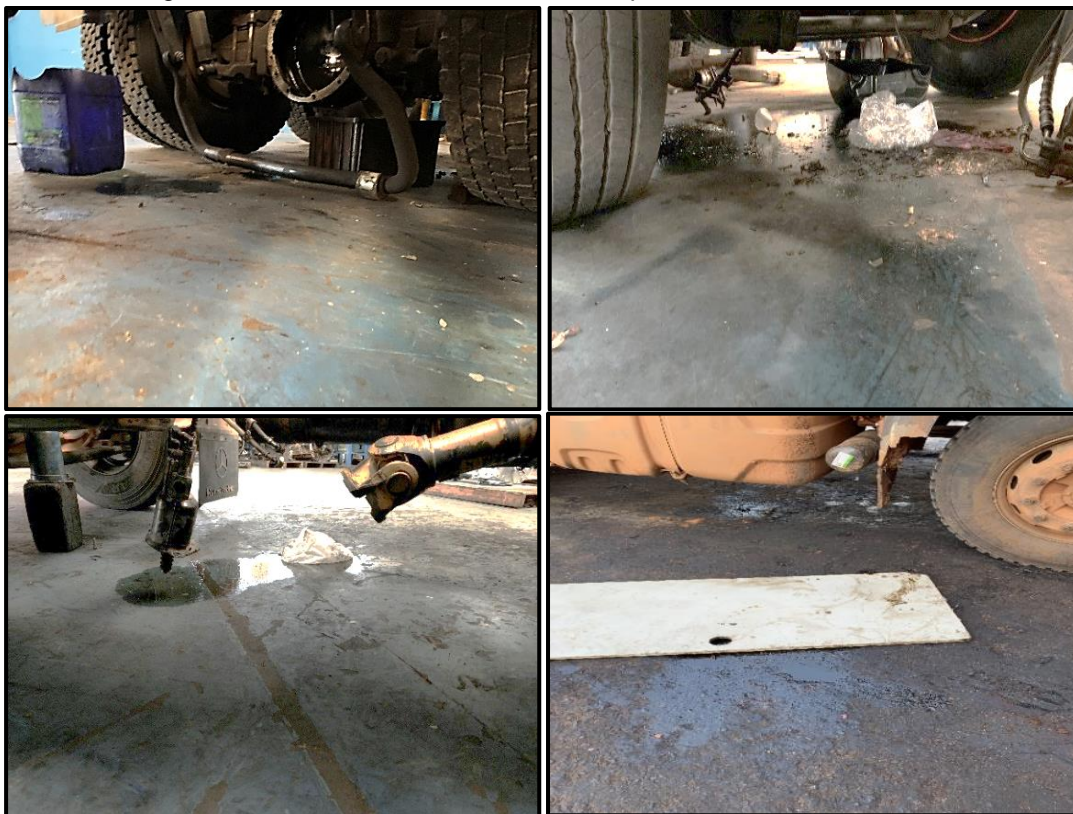
Figura 21 – Estacionamento de veículos, piso com óleo e manchado
