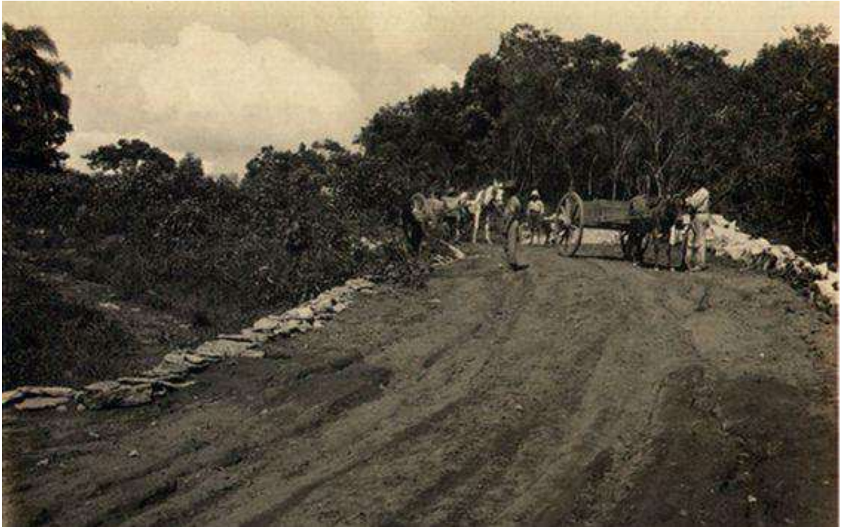
Figura 5 – Corte de morro para ampliação da via original da Estrada da Parada em 19 de março de 1928
