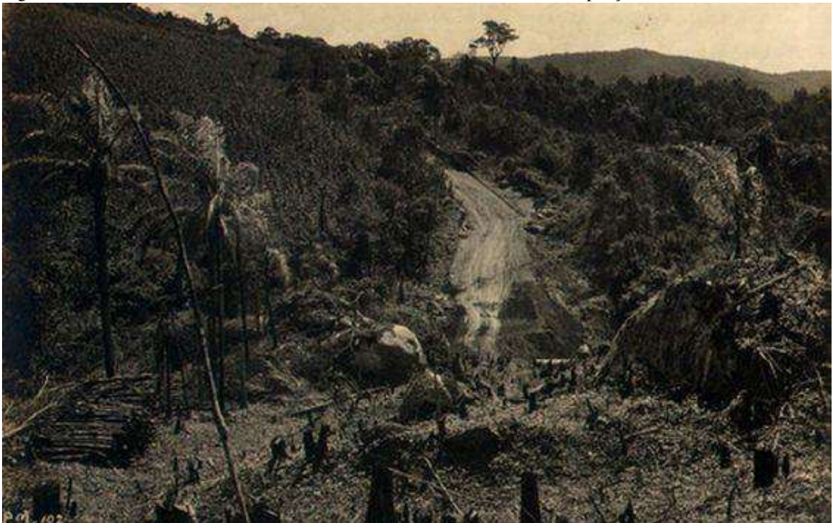
Figura 6 – Retirada de rochas da Estrada da Parada no contexto das obras de ampliação da via
