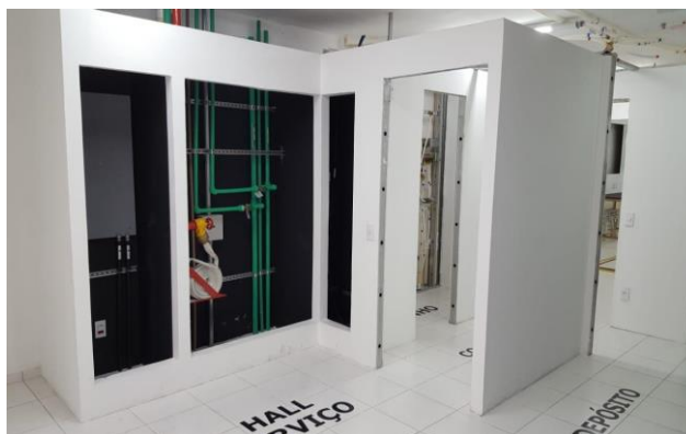
Figura 16 – Hall de serviço
