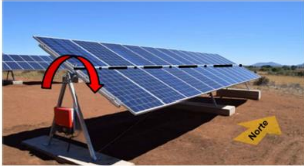
Figura 2.3 – Exemplo de um sistema de rastreamento solar instalado no eixo N-S com movimentação L-O (Patriot Solar Group, 2017).
