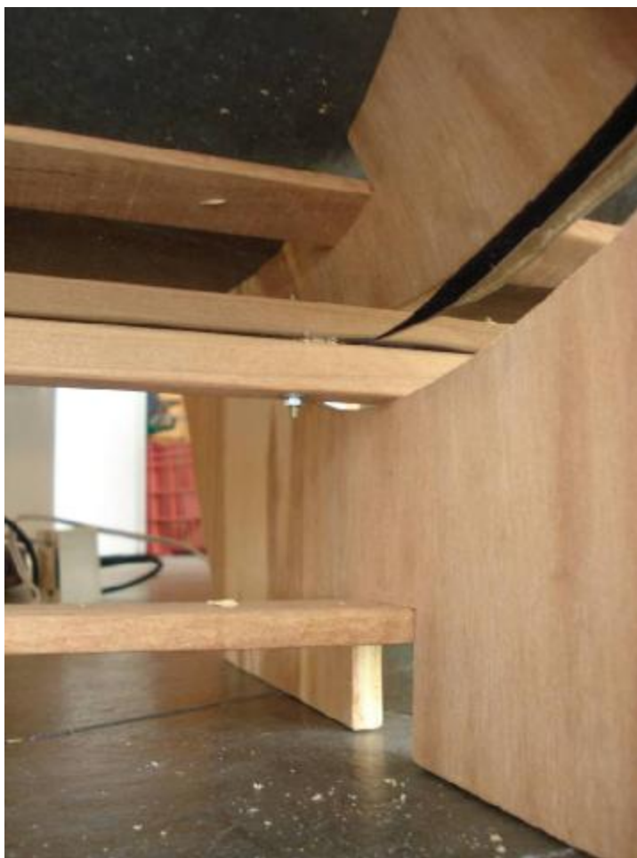
Foto 6 - detalhe do parafuso passante na fixação
