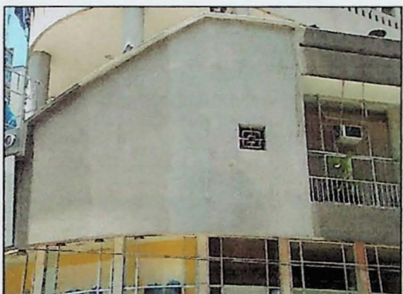
Figura 6.09. Fachada do Edifício Itália com coloração escurecida (à direita) e após lavagem (área mais clara, à esquerda).
