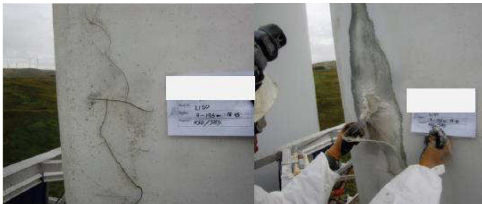
Figura 5.53: Trincas observadas devido ao processo de delaminação
