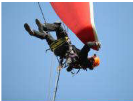
Figura 6.1: Inspeção visual para constatação de dano feita através de acesso por corda
