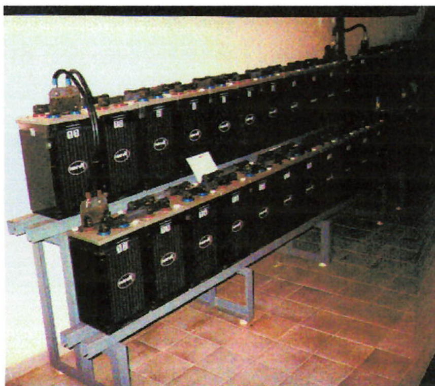
Esquema da sala de baterias de uma ERB da TELESP
