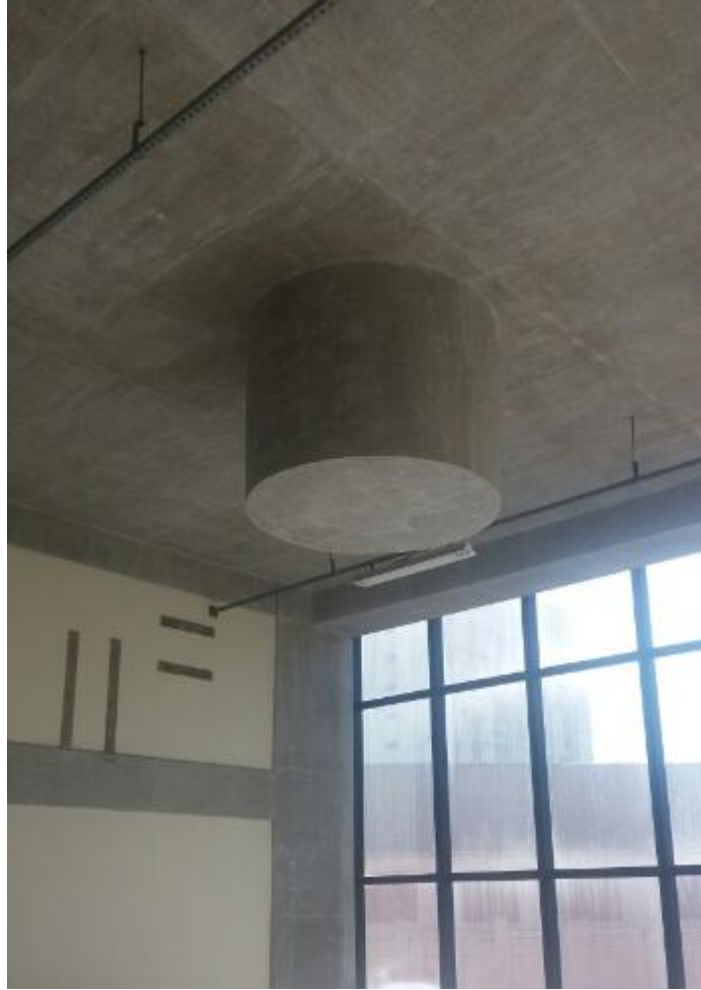
Figura 18 - Fundo cilíndrico dos tanques de decantação
