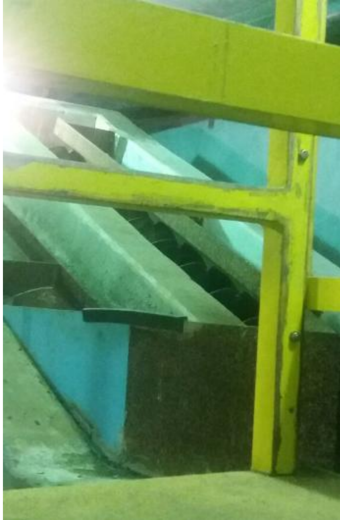
Figura 19 - Mecanismo do tipo parafuso para remoção de areia
