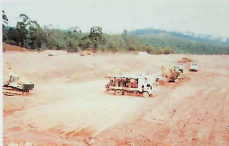
Figura 6. Aterro de Resíduos Perigosos Classe I em fase de obras
