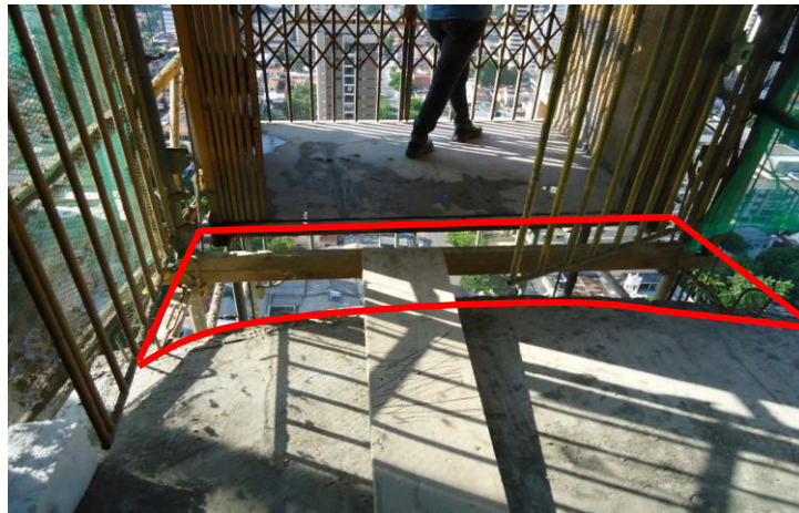
Figura 41: Rampa de acesso a torre do elevador incompleta e inadequada. Fonte: Arquivo pessoal.
