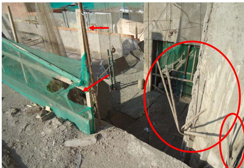
Figura 34: Guarda-corpo danificado e incompleto. Fonte: Arquivo pessoal.
