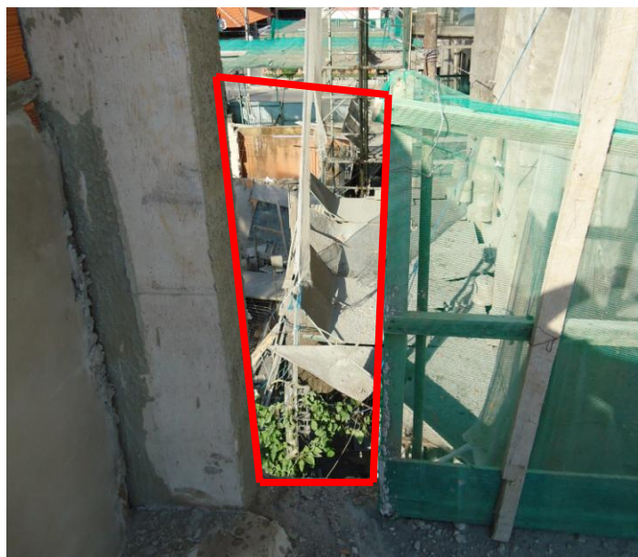
Figura 35: Guarda-corpo incompleto. Fonte: Arquivo pessoal.
