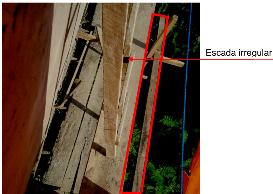
Figura 38: Acesso vertical inadequado. Fonte: Arquivo pessoal.
