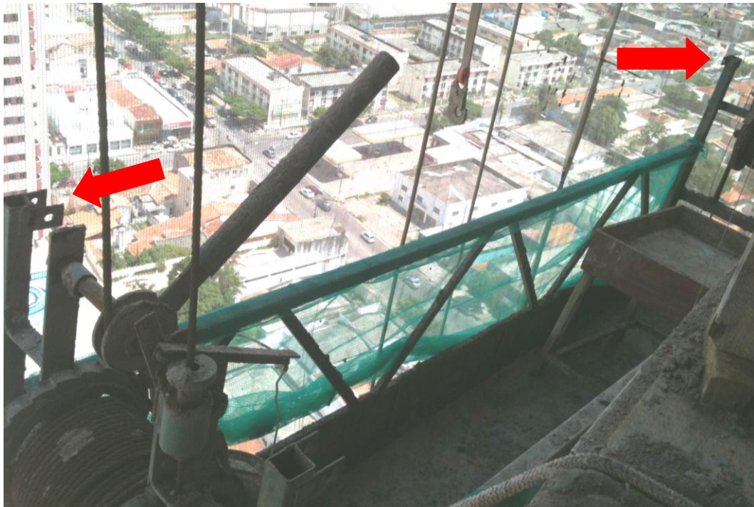
Figura 31: Falta o travessão superior de proteção do andaime. Fonte: Arquivo pessoal.
