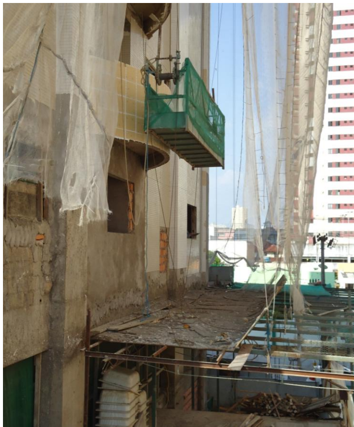
Figura 30: Andaime suspenso mecânico (jaú). Fonte: Arquivo pessoal.
