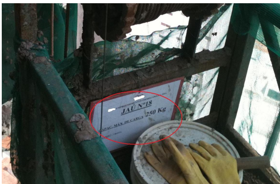
Figura 29: Identificação de andaime por numeração e quantidade de carga. Fonte: Arquivo pessoal
