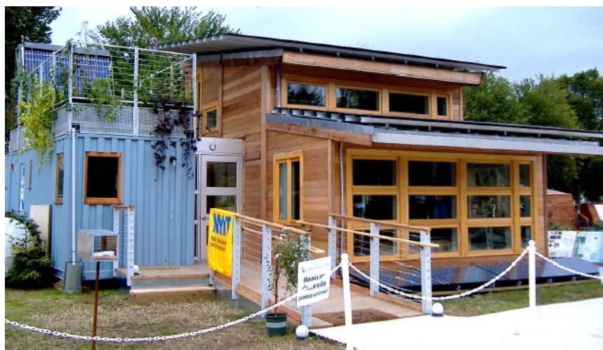
Fig. 5 - Casa equipada com sistema integrado fotovoltaico-hidrogênio.
