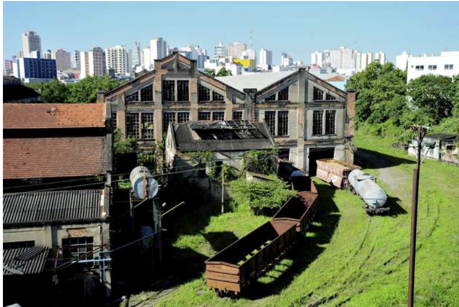
Complexo de edifícios das Oficinas da Sorocabana em estado de abandono
