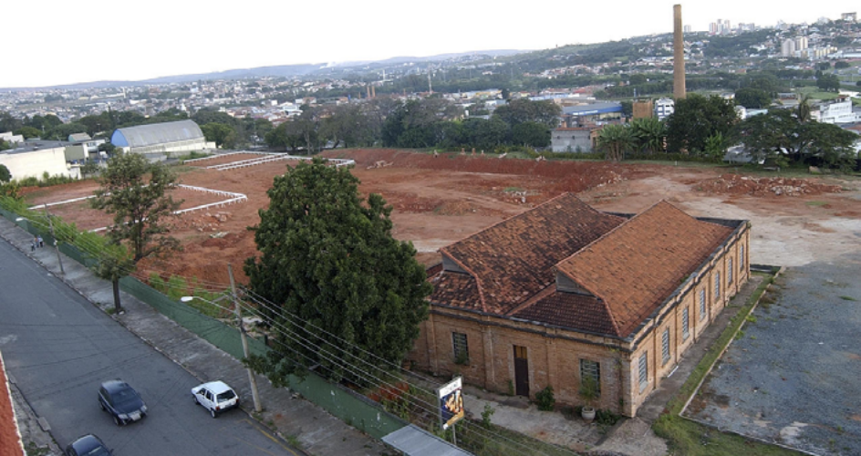
Fábrica Santa Maria após demolição de grande parte do complexo fabril, para construção de torres de apartamentos
