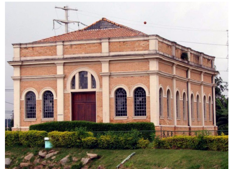
Antiga Usina a diesel da Cianê
