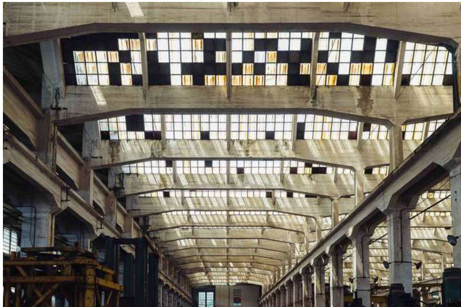
Vista interna de um dos galpões abandonados das Oficinas da Sorocabana
