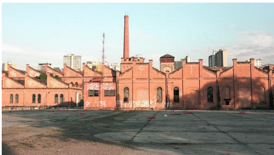
Fábricas Nossa Senhora da Ponte e Santo Antônio antes de obra de restauro
