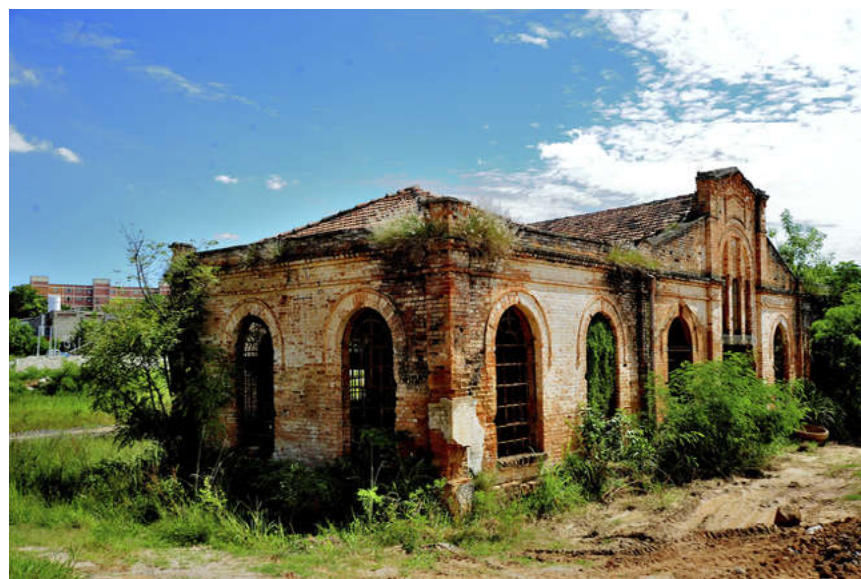
Antigo Matadouro Municipal em estado de abandono
