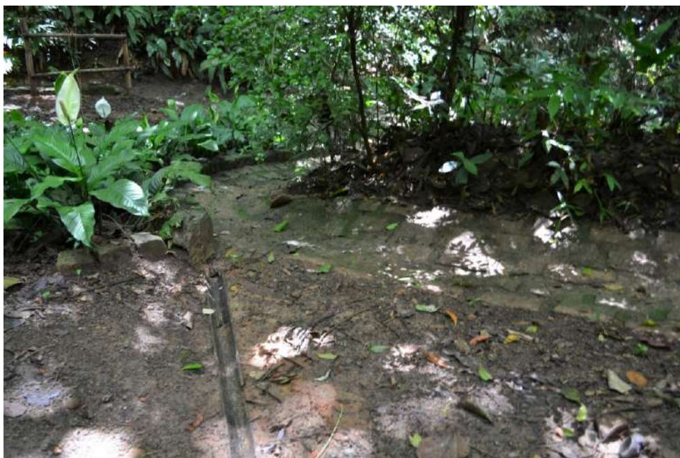
Figura 21: Canaletas de bambu. Fotografia: Gabriel B. de A. Dayan, 2017.
