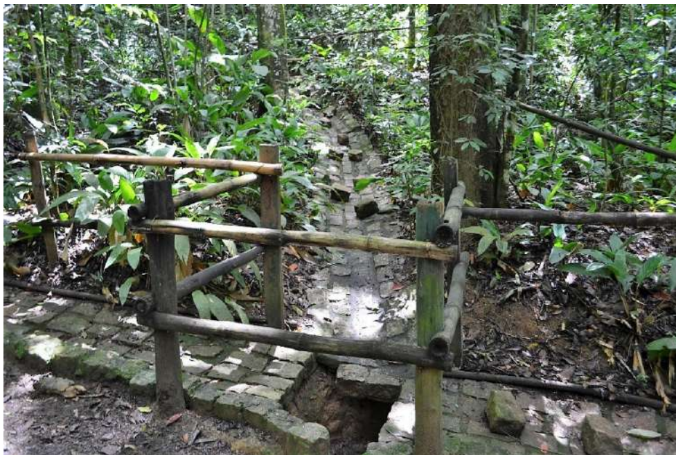
Figura 20: Canaletas de rocha e caixa coletora. Fotografia: Gabriel B. de A. Dayan, 2017.
