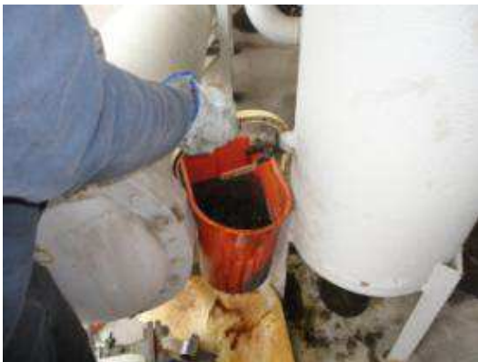
Figura 19 - Retirada do Óleo antigo
