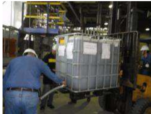
Figura 20 – Inserção do novo óleo no equipamento
