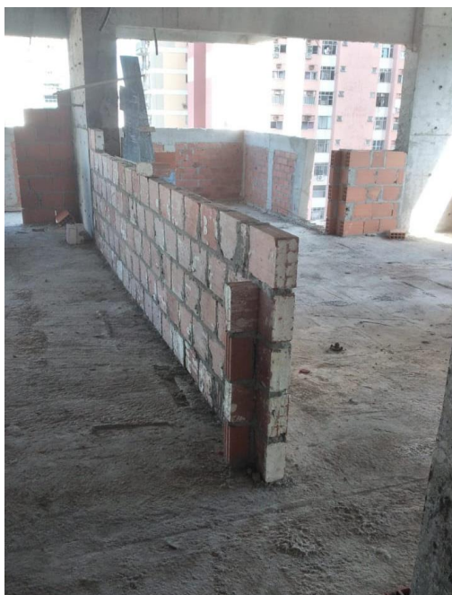
Figura 23 - Execução de parede com blocos cerâmicos preenchidos com gesso in loco
