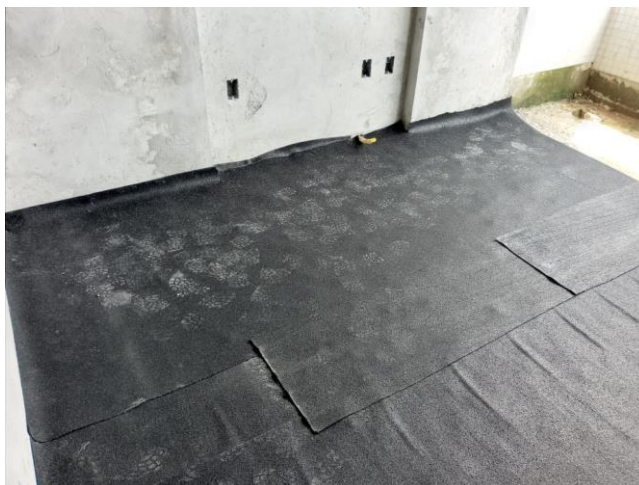
Figura 24 - Colocação da manta sob o contrapiso durante obra no edifício similar ao em estudo.
