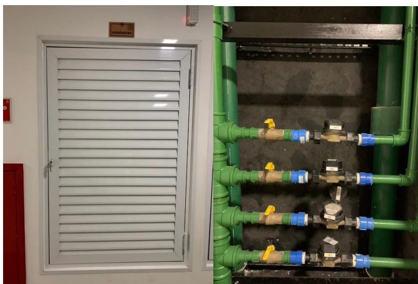
Figura 21 - Shaft hidráulico acabado no edifício similar do empreendimento em estudo
