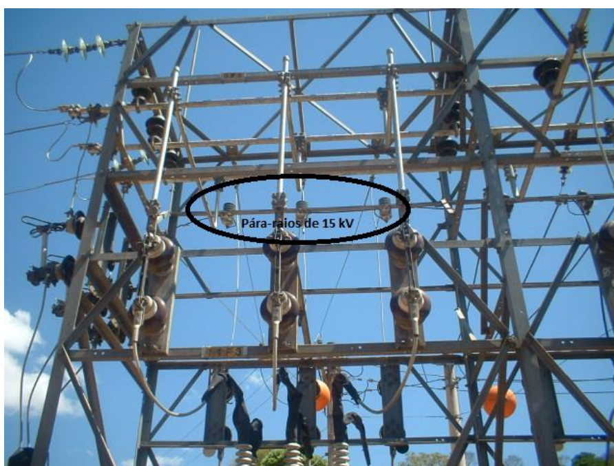
Figura 7: Exemplo para-raios tipo estação 15 kV Fonte: Arquivo pessoal - SE Concessionária, 2012
