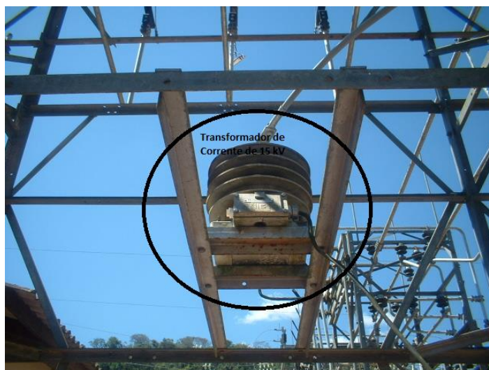
Figura 10: Exemplo de transformador de corrente – 15 kV Fonte: Arquivo pessoal - SE Concessionária, 2012
