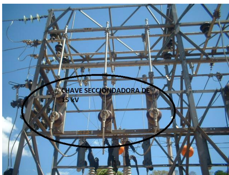
Figura 9: Exemplo de chave seccionadora tripolar – 15 kV Fonte: Arquivo pessoal - SE Concessionária, 2012.
