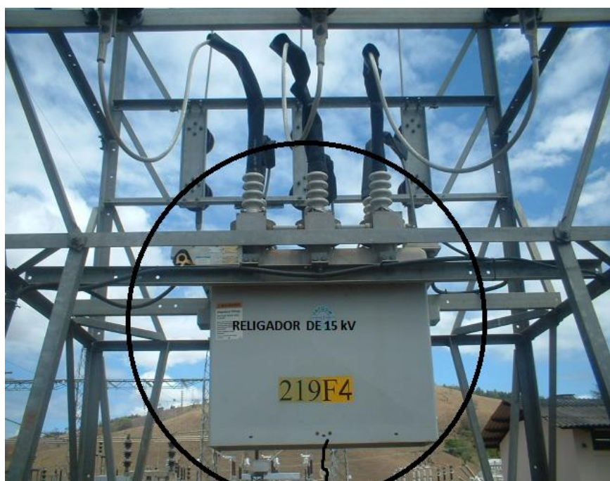
Figura 8: Exemplo de religador trifásico 15 kV Fonte: Arquivo pessoal - SE Concessionária, 2012
