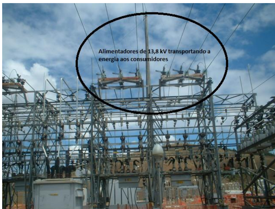
Figura 5: Exemplo de pórtico 13,8 kV, saída rede média tensão Fonte: Arquivo pessoal - SE Concessionária, 2012
