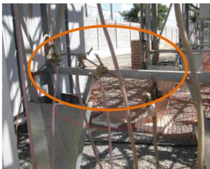
Ponto de conexão do conjunto de aterramento temporário na malha no vão 14F
