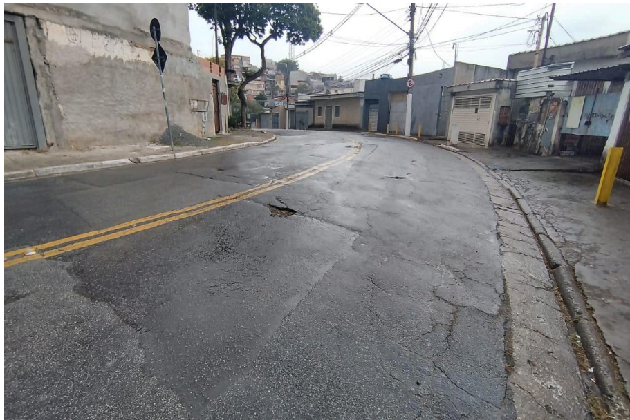
Figura 29 - Microerosões no asfalto. Ponto 10. Rua Gonçalo Fernandes, 279, São Paulo/SP. Orientação da foto: S. Fonte: Sousa, 2025.
