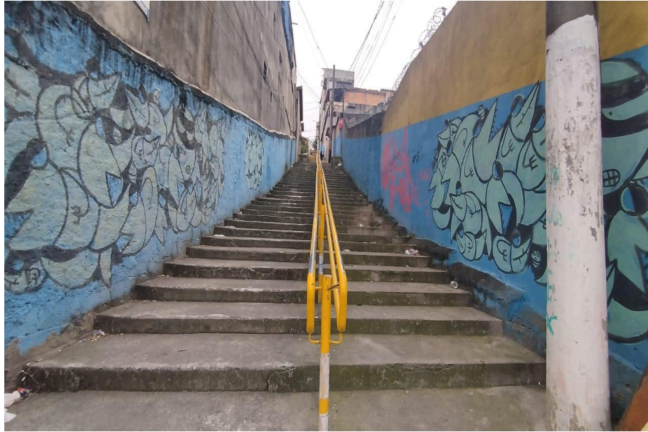
Figura 22 - Escadão sem vala de drenagem. Ponto 2. Rua Estevão Fernandes, 47, São Paulo/SP. Orientação da foto: L. Fonte: Sousa, 2025.
