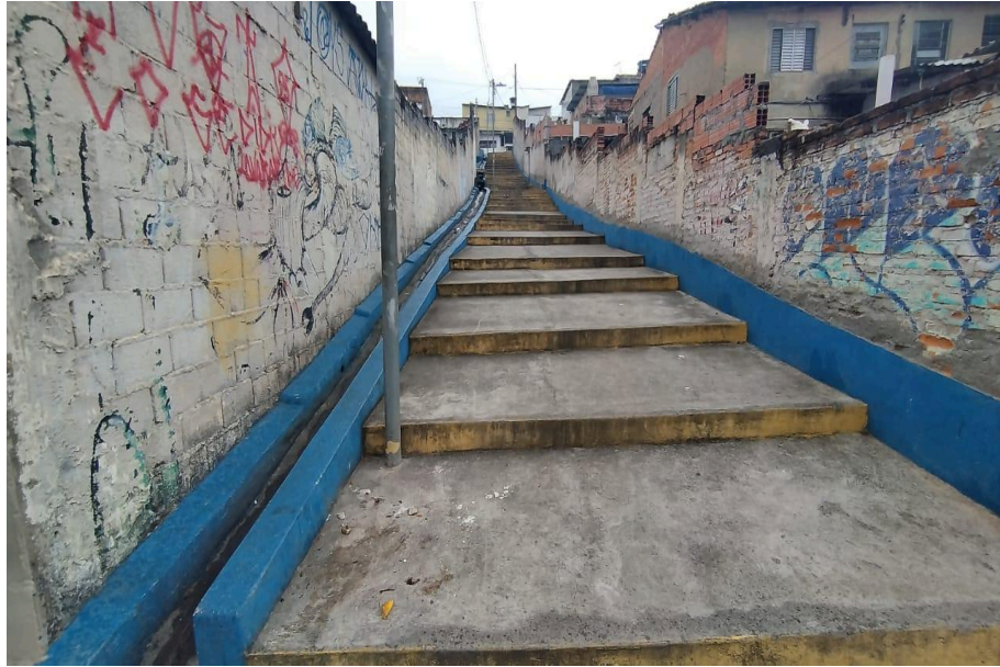
Figura 28 - Escadão com vala de drenagem. Ponto 9. Rua Gonçalo Fernandes, 112, São Paulo/SP. Orientação da foto: S. Fonte: Sousa, 2025.
