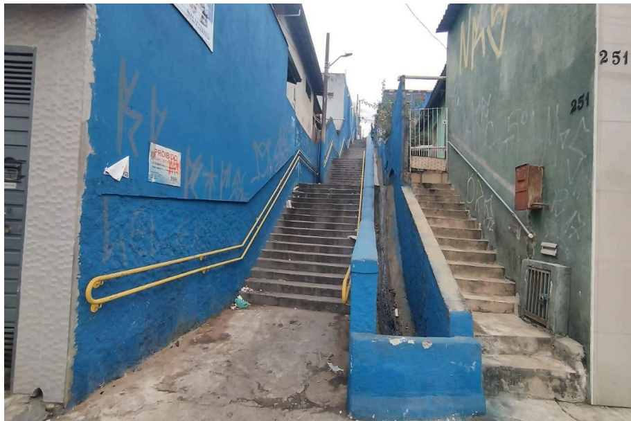
Figura 23 - Escadaria com vala de drenagem. Ponto 3. Rua Estevão Fernandes, 251, São Paulo/SP. Orientação da foto: NO. Fonte: Sousa, 2025.
