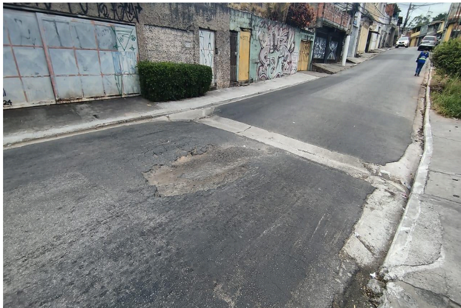
Figura 25 - Erosão no asfalto. Ponto 6. Rua Antônio Vieira Mistura, 406, São Paulo/SP. Orientação da foto: SE. Fonte: Sousa, 2025.
