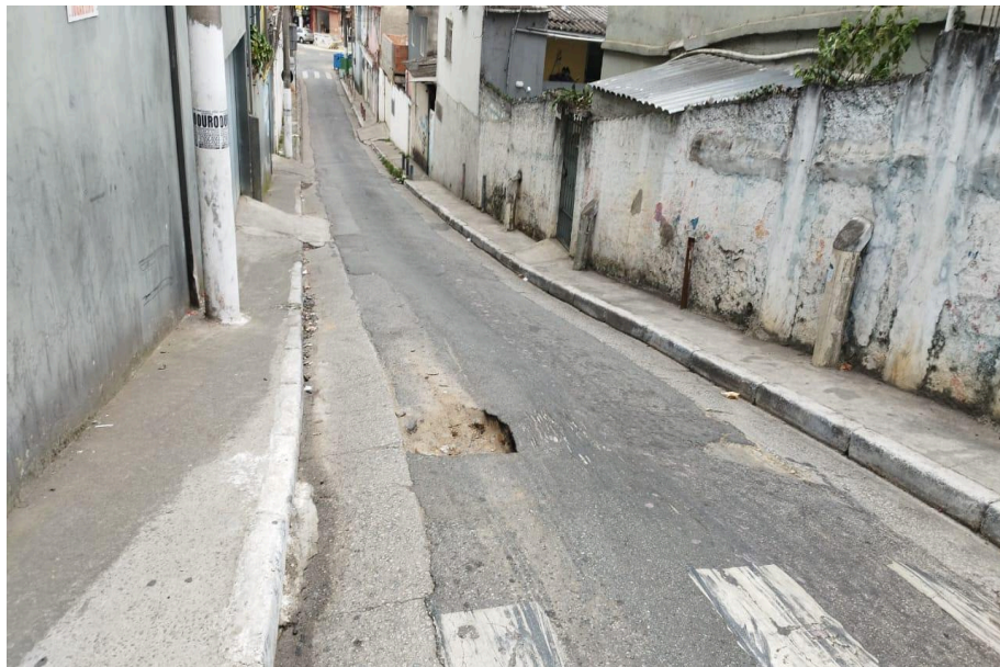
Figura 27 - Erosão no asfalto. Ponto 8. Rua Domingos Afonso Sertão, 269, São Paulo/SP. Orientação da foto: SE. Fonte: Sousa, 2025.
