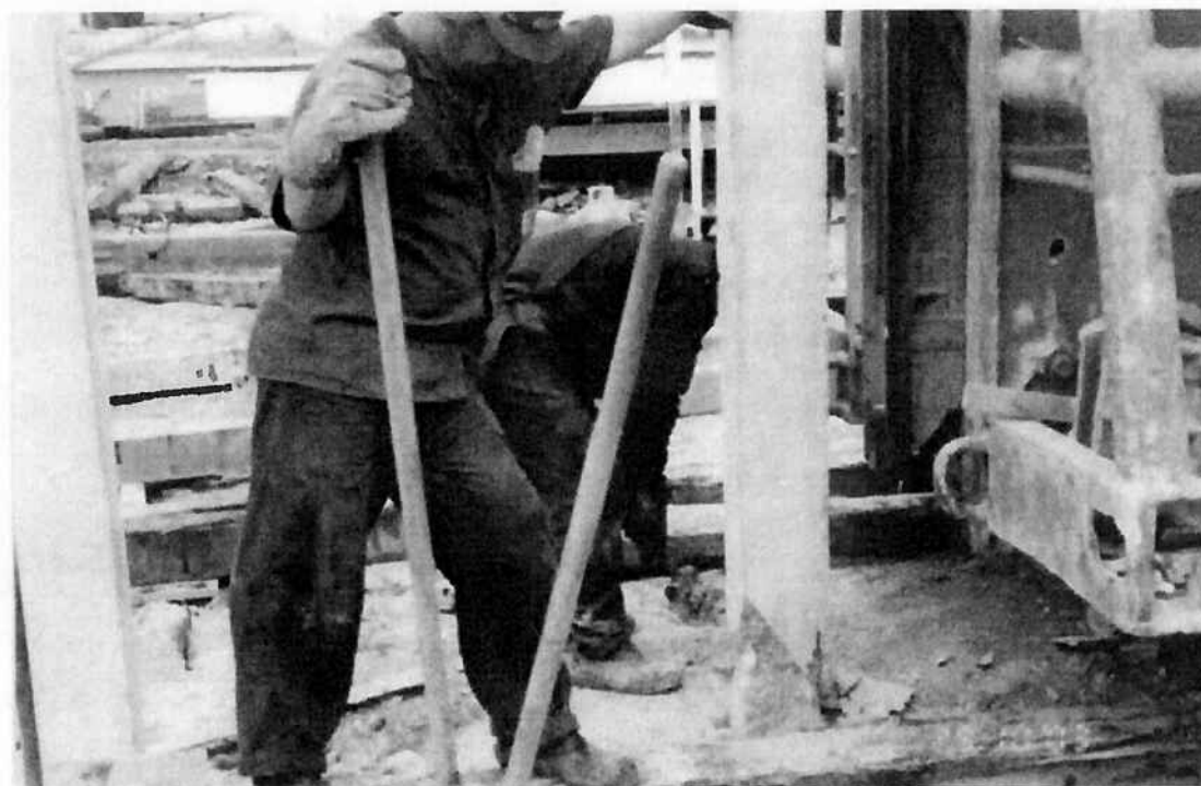
Quebra de estaca antes do término da cravação determinada em projeto.
