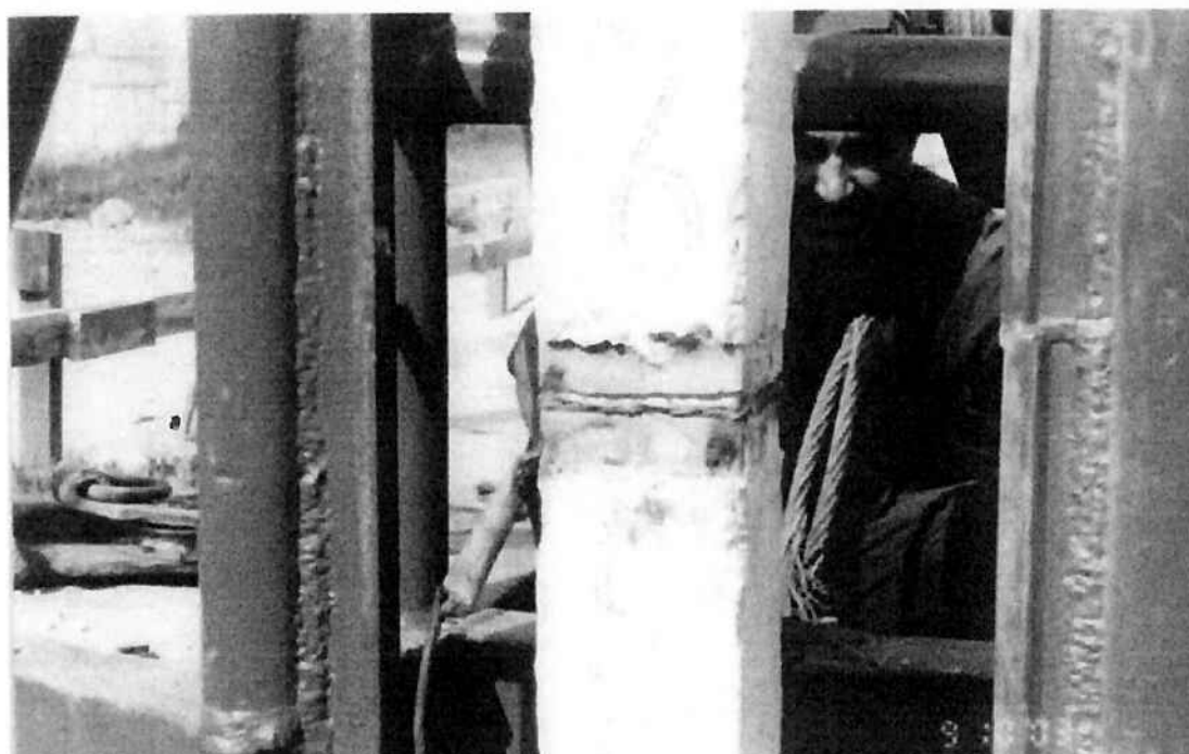
Emenda de estaca com solda elétrica (prever fornecimento de energia elétrica adequada).
