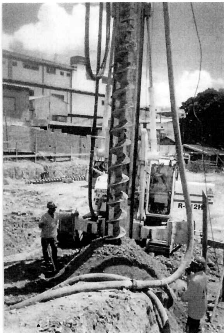
Seção 1.17 Final da concretagem de uma estaca.
