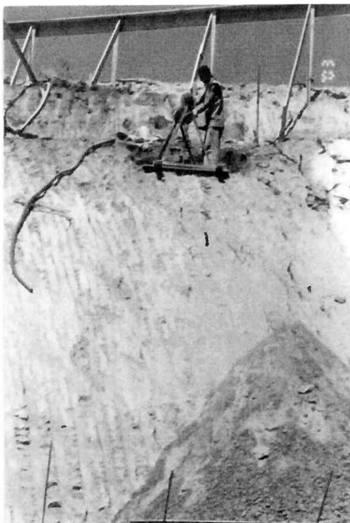
Exemplo de mobilidade, execução de tubulão em talude.
