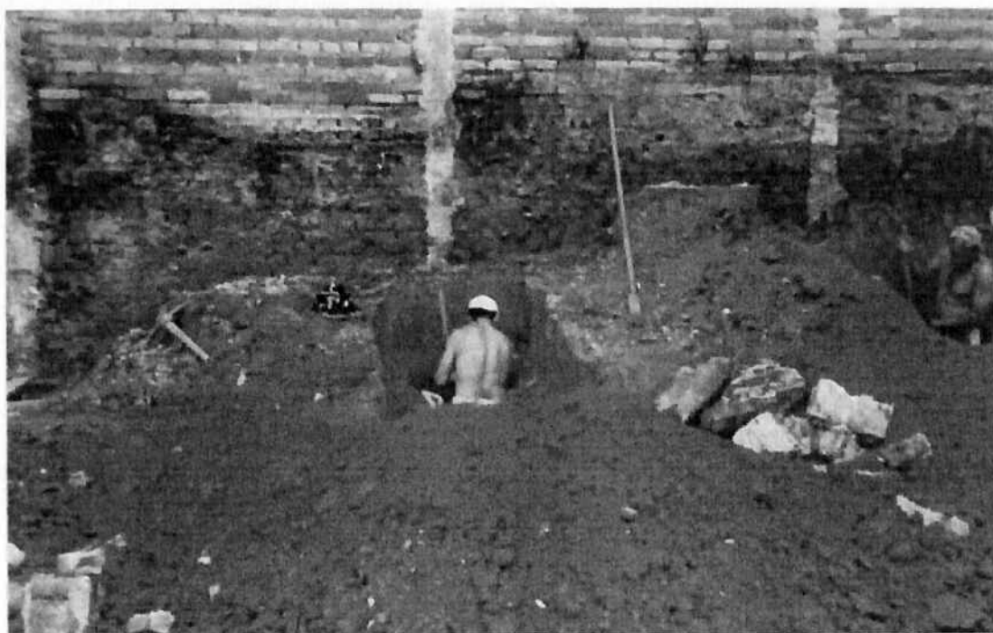
Execução das "bocas" dos tubulões, momento em que os poceiros trabalham separados.
