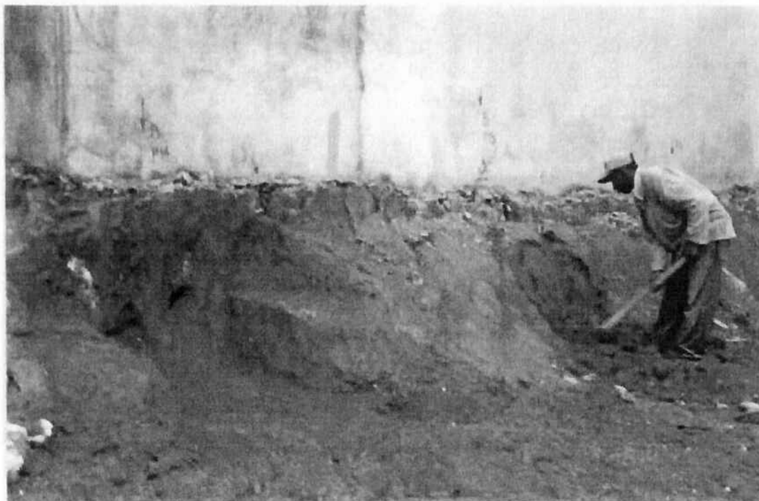
Execução dos chamados "cachimbos" para posterior escavação do tubulão. Após acordo entre as partes (obra e empreiteiros), o servente da obra executou o serviço.
