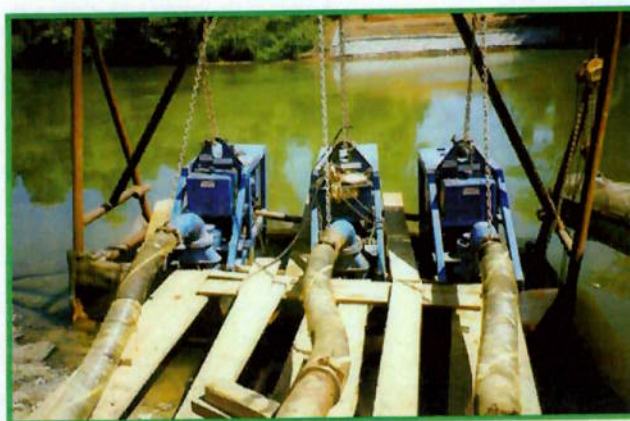
Figura 26 – Bombas de captação da água para realização do teste hidrostático.
