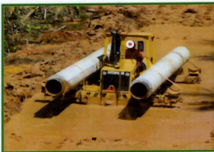
Figura 10 – Transporte de tubos em área alagada.
