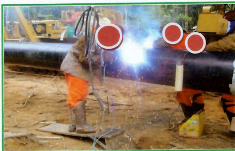
Figura 15 – Processo de soldagem em tubulação.
