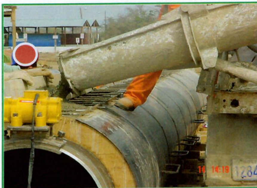
Figura 14 – Concretagem de tubos evitando despejo de concreto no solo.
