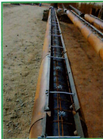
Figura 13 – Preparação para concretagem de tubos.
