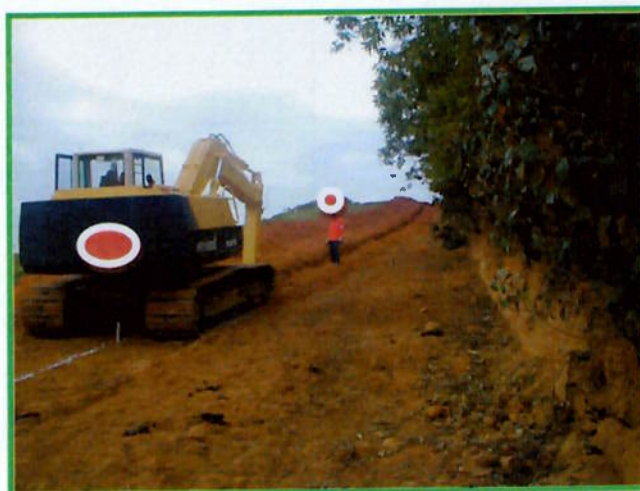
Figura 8 – Abertura e preparação da vala.
