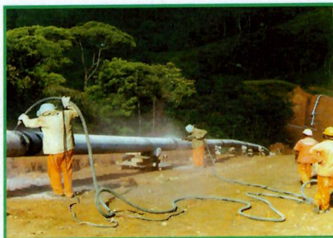
Figura 17 - Limpeza de juntas por jateamento.
