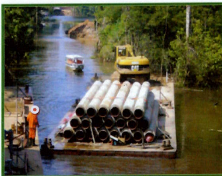
Figura 11 – Transporte de tubos por meio de balsa.
