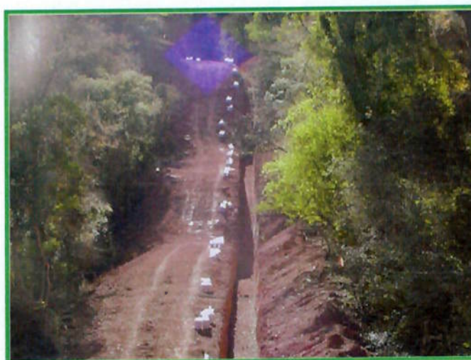
Figura 9 – Vista da vala aberta na faixa domínio.
