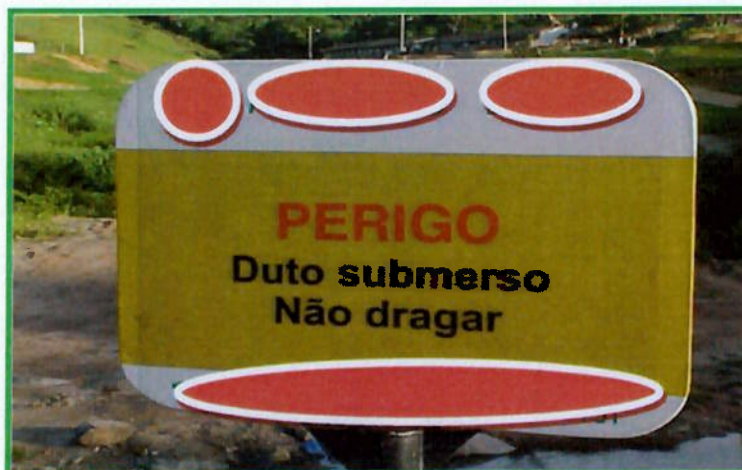
Figura 23 – Exemplo de placa sinalizadora de duto.
