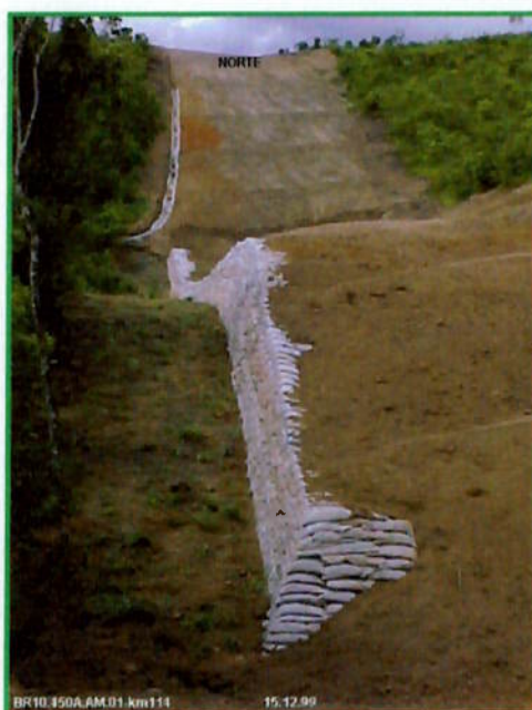
Figura 24 – Exemplo de muro de contenção em obras de gasoduto.
