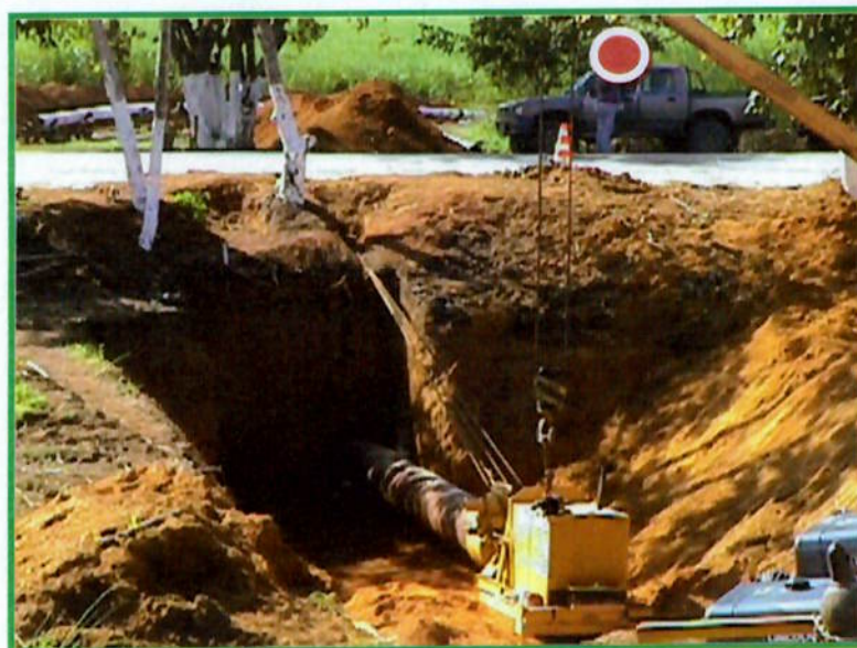
Figura 22 – Instalação de gasoduto em travessias.
