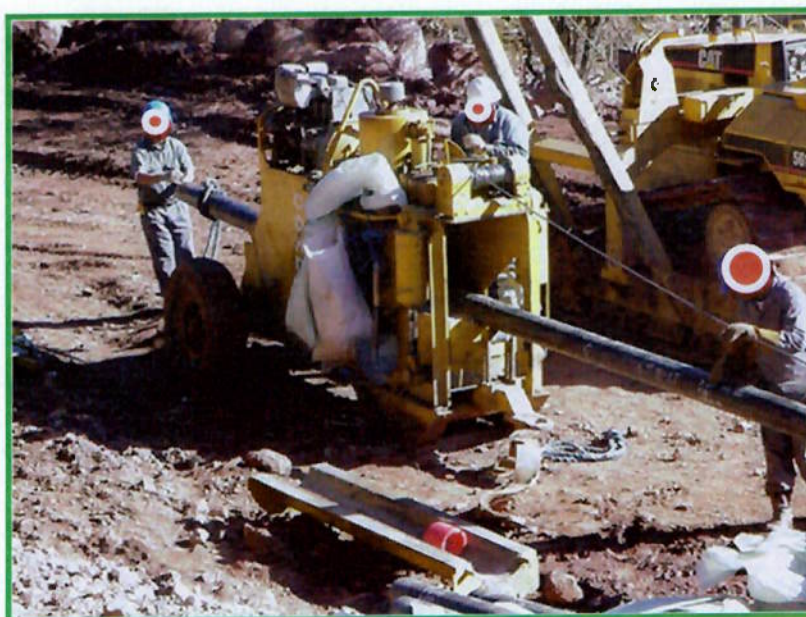
Figura 12 – Curvamento de tubo em obras de gasoduto.
