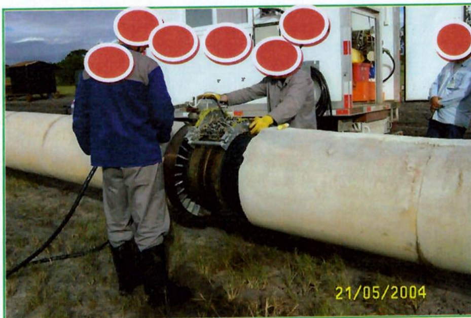
Figura 16 – Realização de END por ultrassom.
