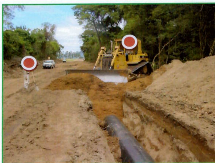
Figura 20 – Cobertura da vala.
