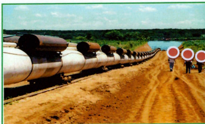
Figura 21 – Coluna pronta para lançamento na travessia.
