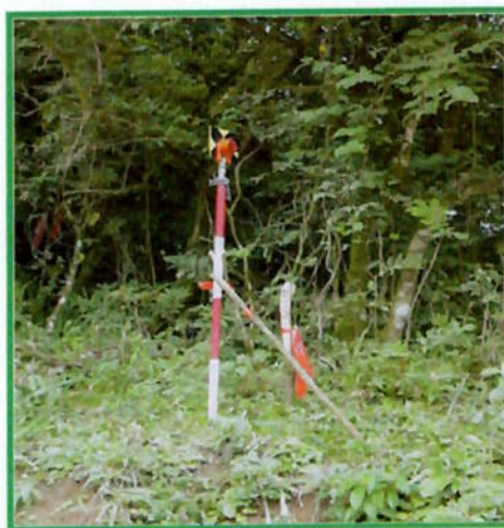
Figura 5 - Teodolito utilizado pelos topógrafos para locar a faixa domínio do gasoduto.
