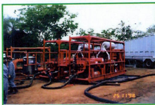
Figura 27 – Bombas de enchimento da tubulação – preparação do teste hidrostático.
