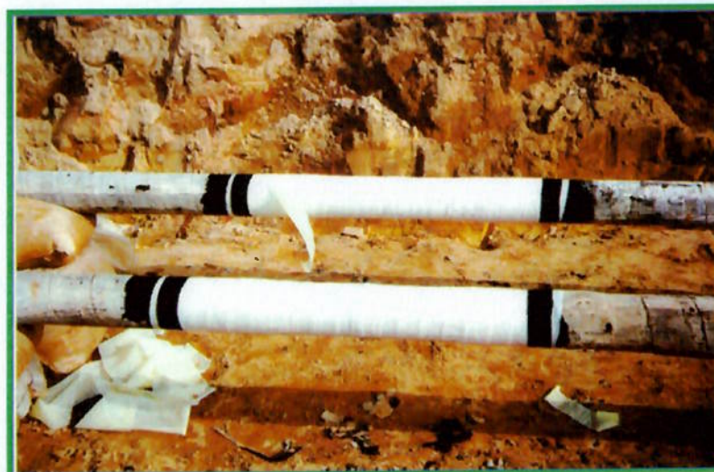
Figura 18 – Revestimento com fitas de polietileno.
