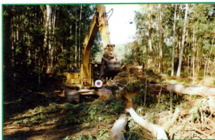
Figura 7 – Supressão vegetal para abertura de pista.
