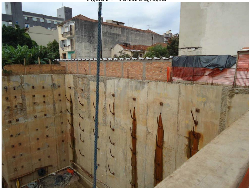
Figura 5-7 - Parede Diafragma
