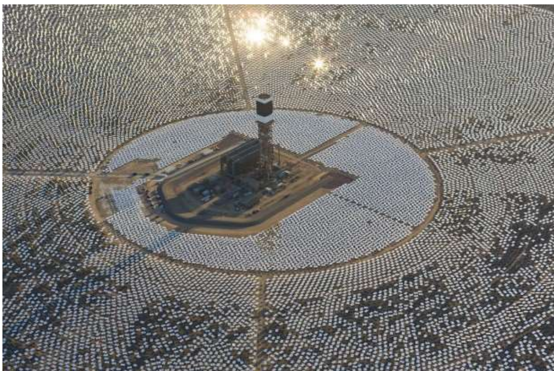
Figura 23 - Usina de Ivanpah, Califórnia. 392 MW instalados
