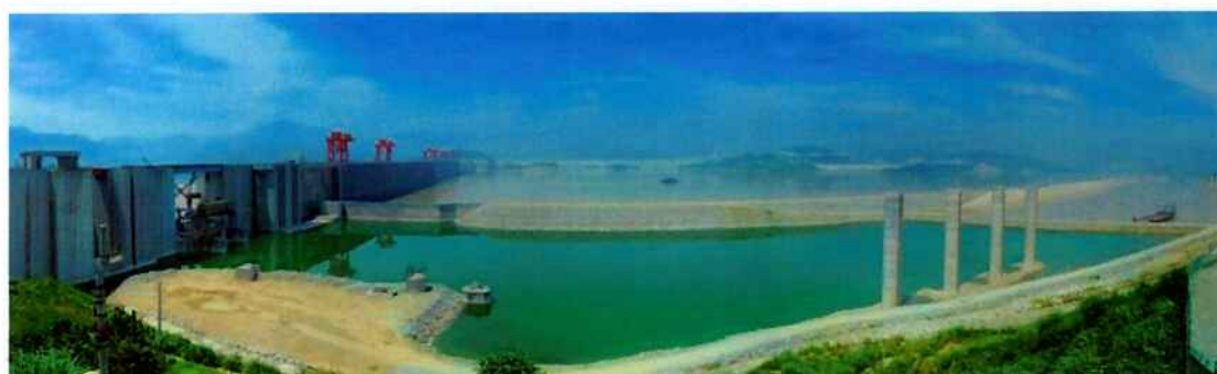
Lado alto da usina
