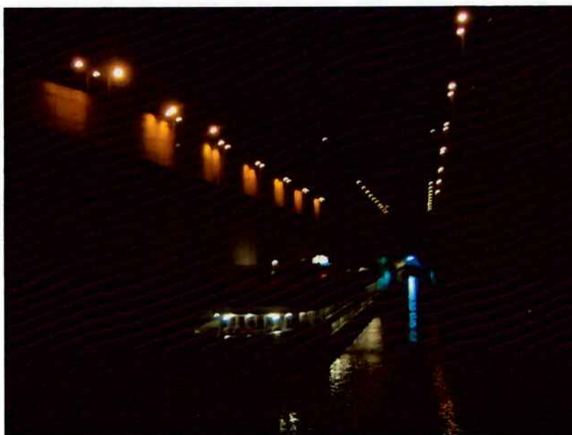
Interior da usina
