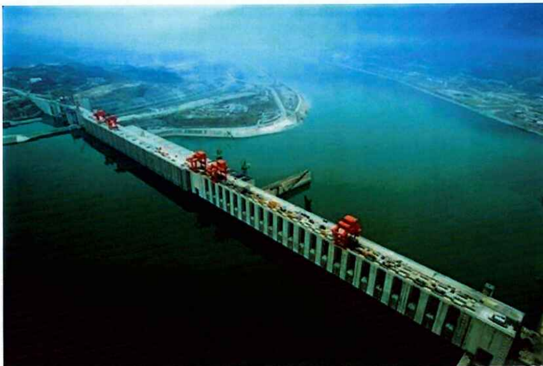
Visão aérea em 2005 mostrando o eixo da barragem, de 2,3 km
