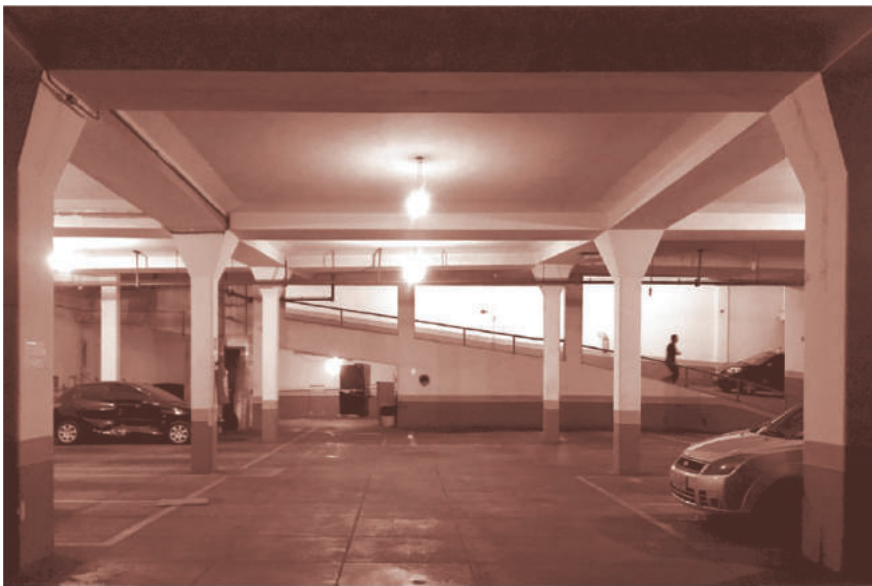
figura 36 · Cine e edifício Esmeralda, vista do estacionamento (28 de março de 2018, foto da autora)
