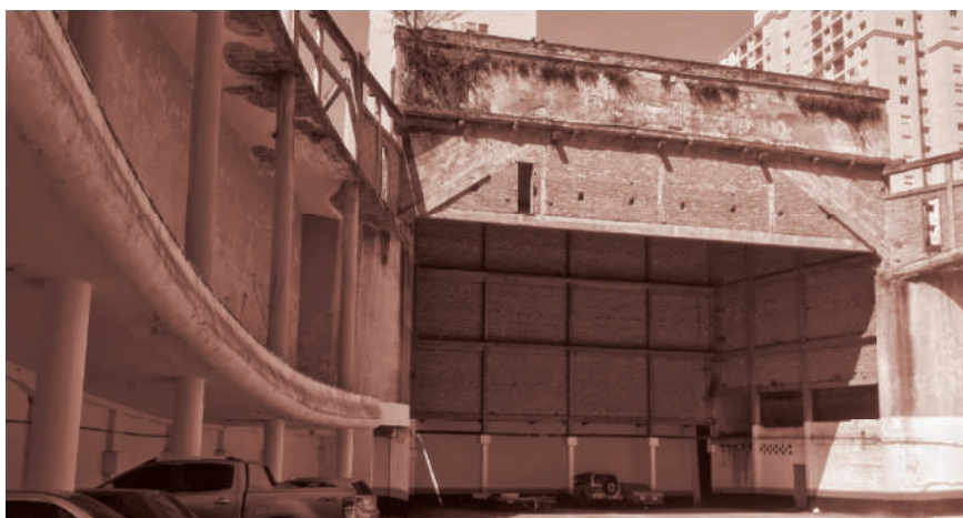
figura 16 · Cine Piratininga (1943), vista da fachada para Av. Rangel Pestana, Brás (13 de setembro de 2017, foto da autora)
