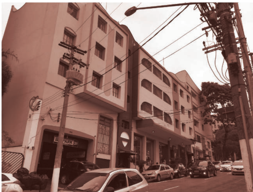
figura 20 · Cine Astral (1957), vista da fachada para a Rua Cotoxó. Atualmente sua sala funciona como estacionamento e o foyer foi substituído por comércio (11 de março de 2018, foto da autora)
