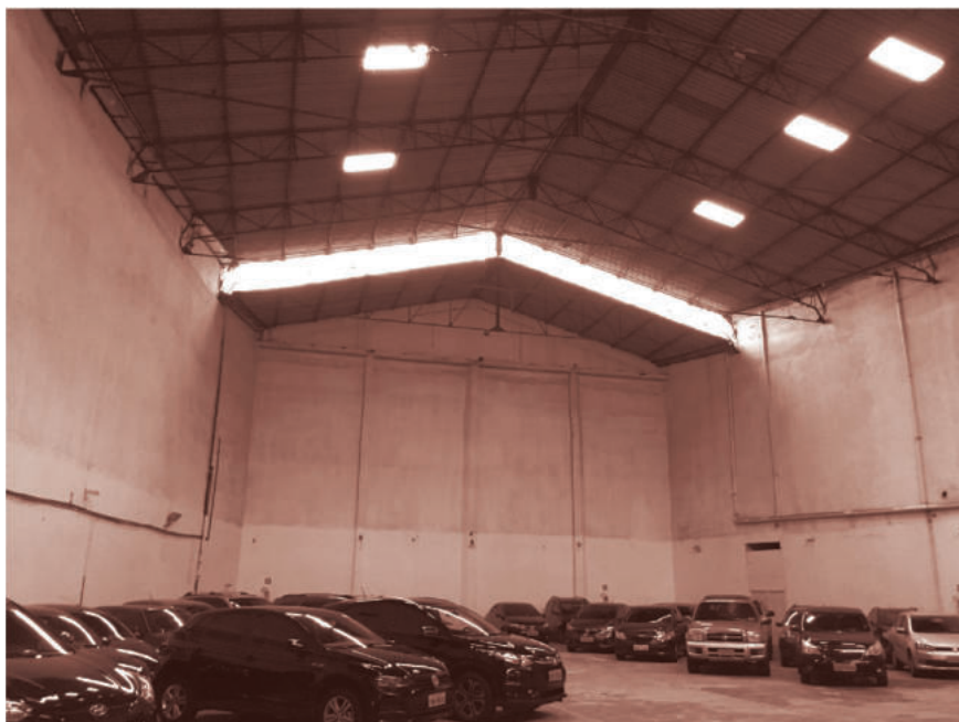
figura 19 · Cine Astral (1957), vista da sala de cinema. Segundo relatos, após o fechamento do cinema, este edifício funcionou como teatro até ser fechado devido à incêndio em seu interior (11 de março de 2018, foto da autora)
