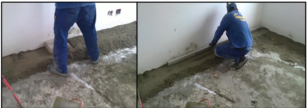
Figura 12: A foto à esquerda ilustra a compactação do contrapiso com um peso de madeira. A foto à direita ilustra o sarrafeamento do contrapiso com uso de uma régua de alumínio.
