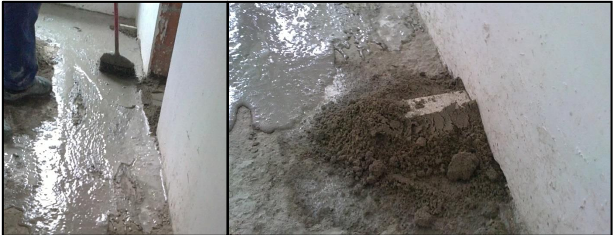
Figura 11: A foto à esquerda ilustra a aplicação de camada adesiva. A foto à direita ilustra a talisca, como referência de nível
