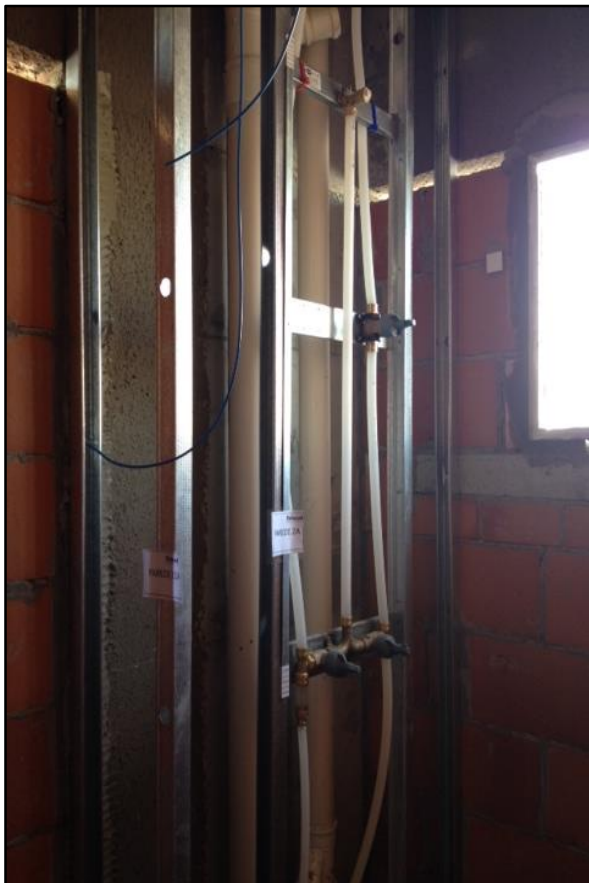
Figura 9: Figura ilustrativa de kit hidráulico. O modelo estudado é com tubulação de cobre (Fonte autor, 2014)
