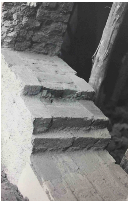
FIGURA 15 - FOTO ESPESSURA DA PAREDE MESTRA (ENPENA)
