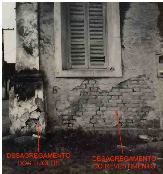
FIGURA 44 - LEV. FOTOGRÁFICO - DESAGREGAÇÃO TIJOLOS E REVESTIMENTOS
