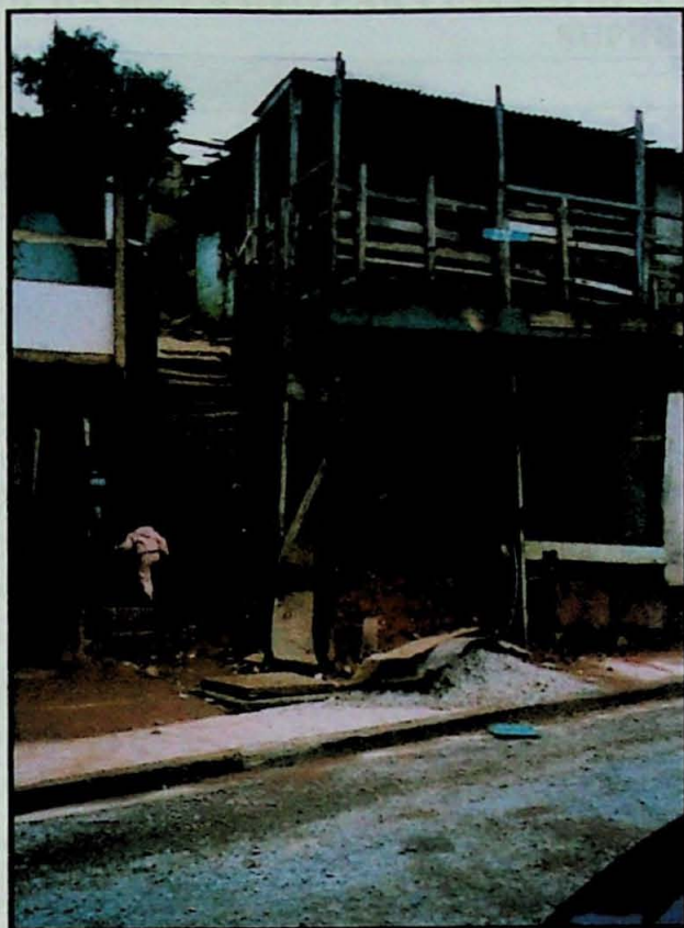
FC-RP-09. Vista de um bar construído sobre um pequeno talude de corte, o qual está sendo tratado, a fim de que sejam evitados problemas de estabilidade.
