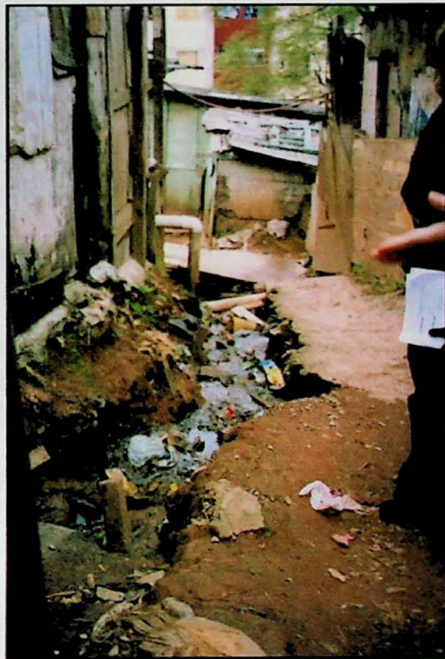
FC-RP-10a. Vista em detalhe do esgoto que desce com grande velocidade, devido à declividade do terreno, o que acarreta erosão acentuada nas bordas do canal. Observam-se muitas trincas no terreno e sulcos de erosão.
