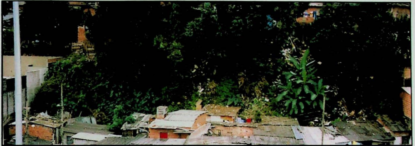
FC-RP-01, FC-RP-01a, FC-RP-01b. Vista geral do talude de corte com altura de 10 m, que apresenta o maior potencial para deflagração de um grande escorregamento. Neste já se observam escorregamentos rasos de pequeno porte.
