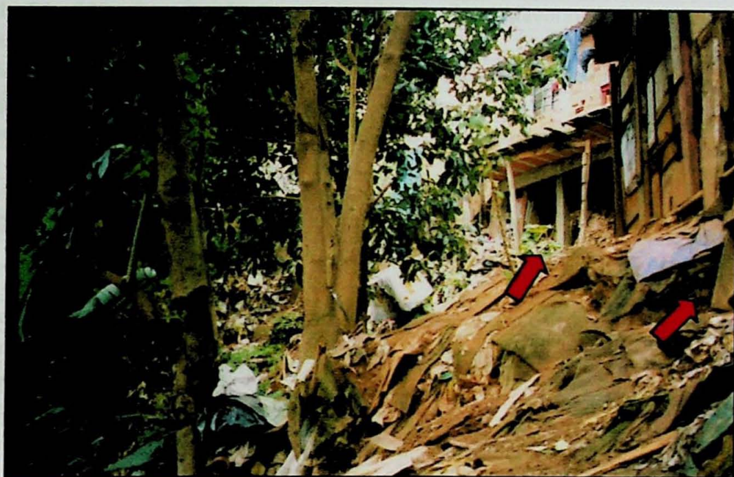
FC-RP-18. Vista geral das moradias localizadas no topo do talude do ponto 1. Observar a grande quantidade de entulho e lixo lançados na superfície do talude e a situação em que se encontram os alicerces das construções.
