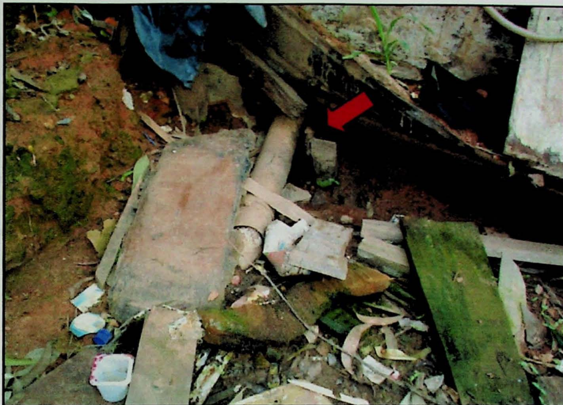
Foto 17 - Vazamento de esgoto gerado por um tubo rompido, o qual ocasionou escorregamento de médio porte no local.
