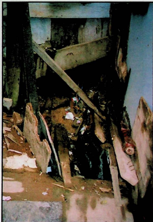
FC-RP-11a. Vista em detalhe do canal onde uma das tábuas que o cobria foi retirada. Observa-se grande quantidade de lixo e entulho que corre junto ao esgoto.
