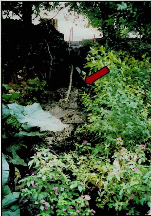
FC-RP-01c. Vista em detalhe de um escorregamento raso recente, ocorrido em um ponto do talude onde um cano lança esgoto do topo do talude para baixo, ao longo de sua superfície.
