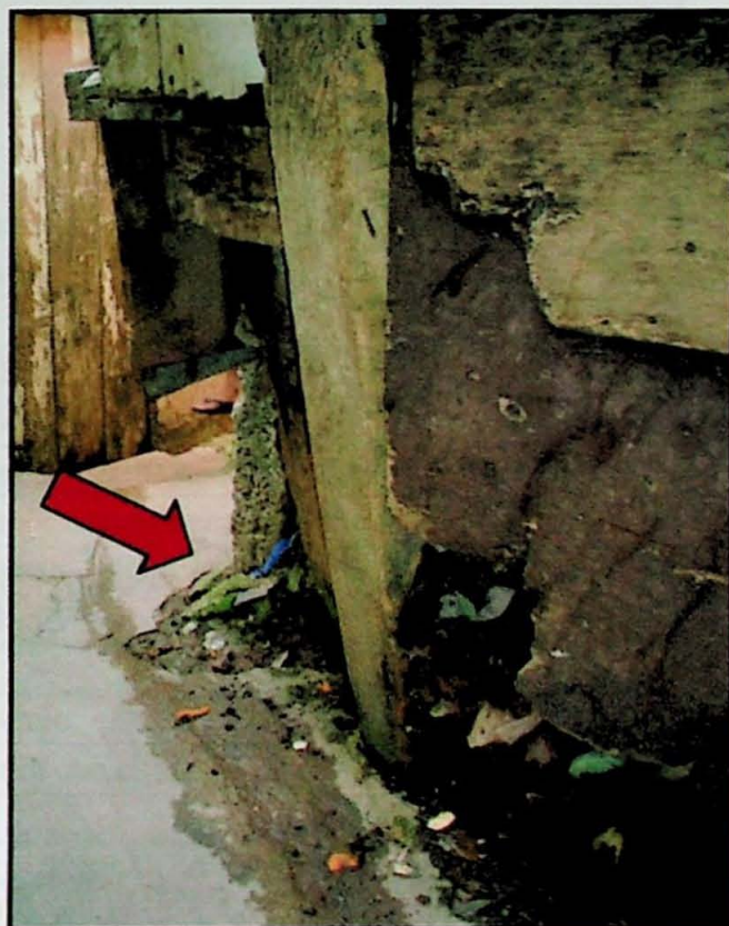
FC-RP-07a. Outra vista em detalhe do início de um solapamento formado em uma das curvas da viela. Grande parte do alicerce da moradia se encontra exposto.
