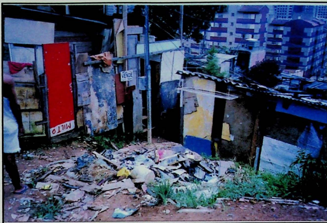
FC-RP-25. Vista geral de talude; observar a inclinação da encosta, os taludes de corte apresentando pequenas dimensões e a grande quantidade de lixo e entulho lançados, além dos sulcos provocados pela erosão.
