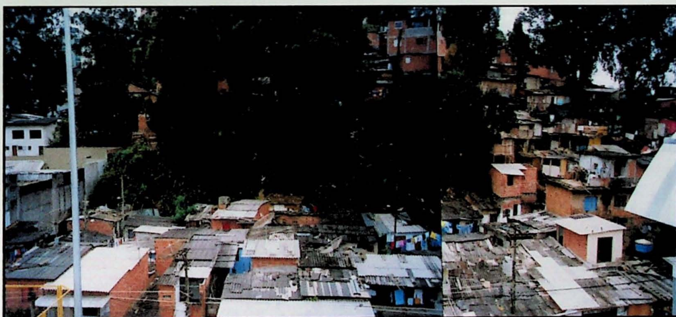
Foto 2 – Vista geral do talude de corte com altura de 10 m, que apresenta o maior potencial para deflagração de um grande escorregamento. Neste já se observam escorregamentos rasos de pequeno porte.
