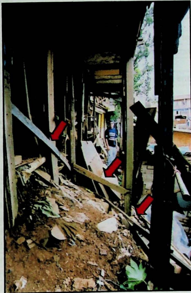
FC-RP-20b. Vista em detalhe do alicerce de uma das moradias onde ocorreu um pequeno escorregamento. Observar que juntamente com a terra movimentada, existem pedaços de sarrafos e caibros de madeira, que foram arrancados do alicerce da construção, desestabilizando a
