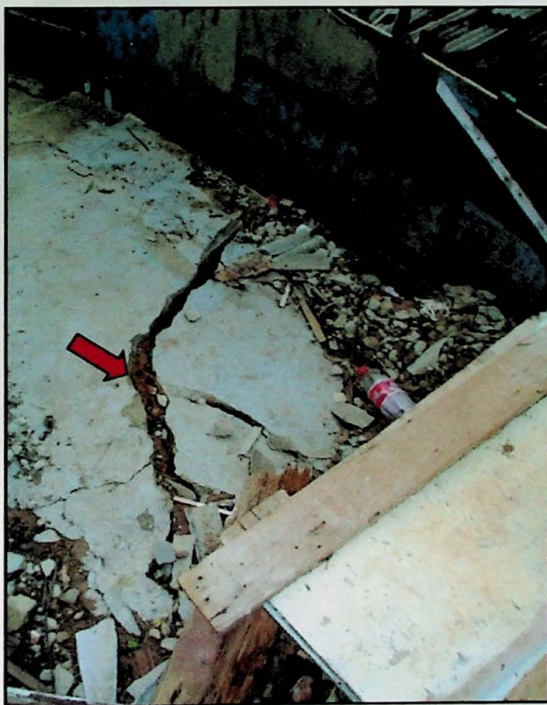
Foto 13 – Presença de trincas na moradia.
