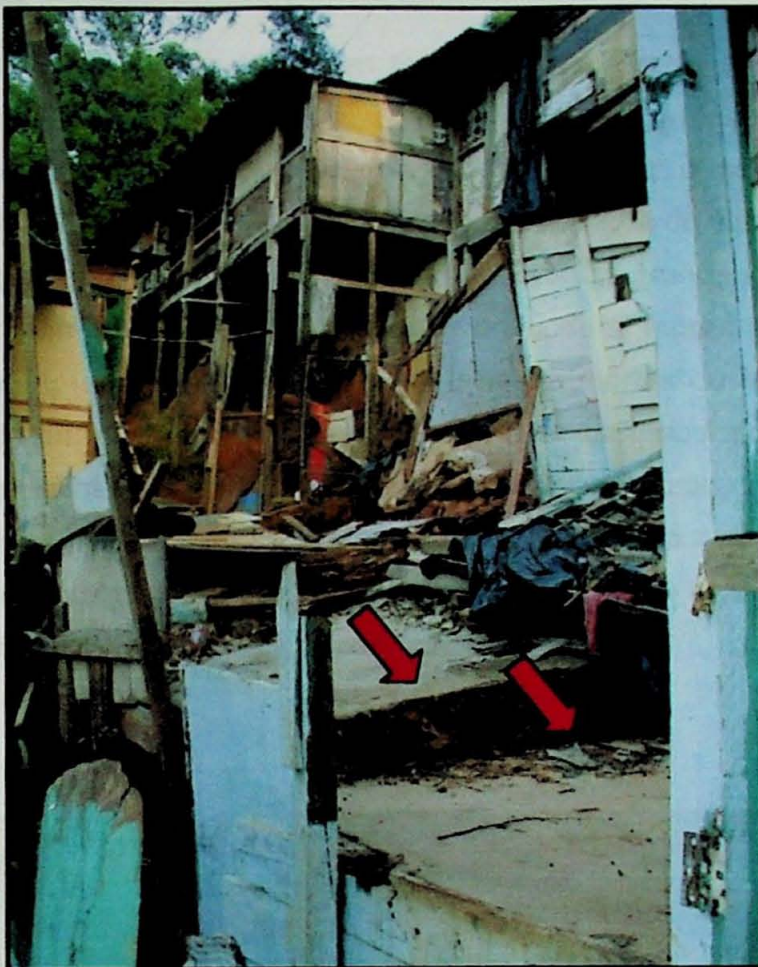
Foto 14 – Observa-se um grande degrau de abatimento em uma das moradias do setor 1, a qual foi atingida por um escorregamento de médio porte.
