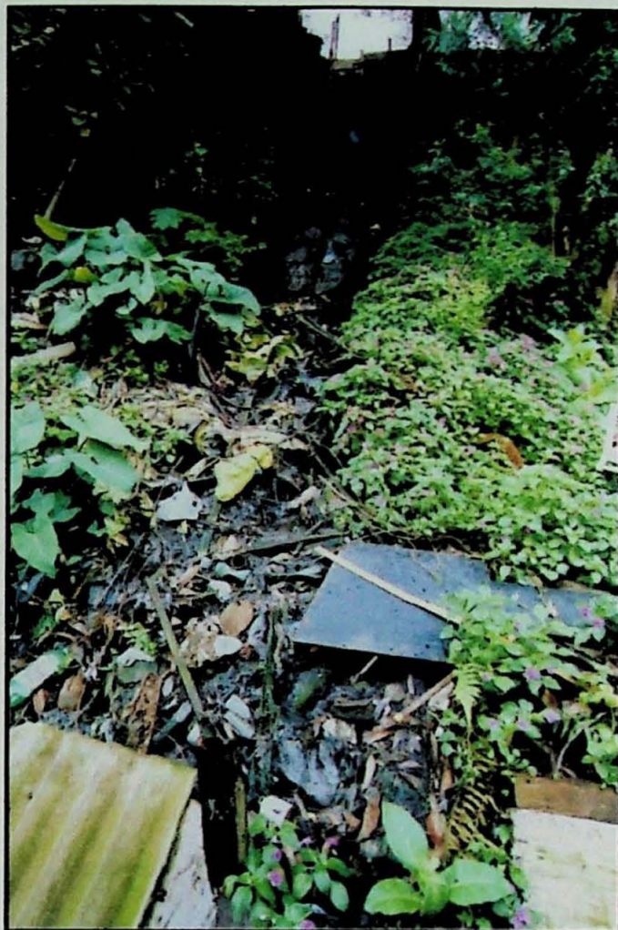
Foto 5 – Observa-se no alto do talude um pequeno degrau de abatimento e na base da foto, o acúmulo do material que escorregou. Grande parte do material escorregado é lixo, sendo este um outro fator agravante na área, além da presença de argilas expansivas e a presença de esgoto jorrando no topo do talude.
