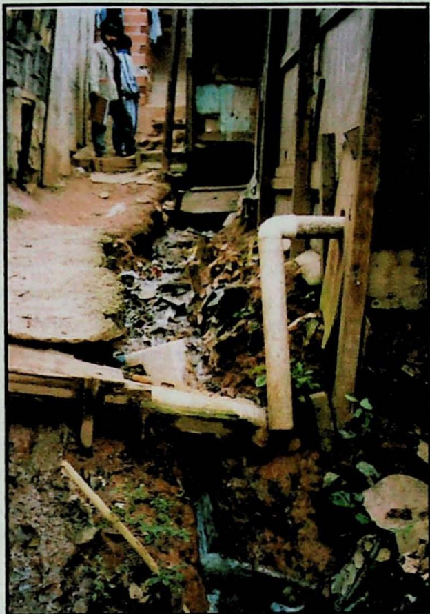
FC-RP-10. Vista em detalhe do esgoto lançado a céu aberto. Todo o esgoto vem do topo do talude, desde a rua Conde de Itaguaí, até desaguar próximo à rua Paulo Borroul. Os moradores abriram um canal para que a água não se espalhe na viela.
