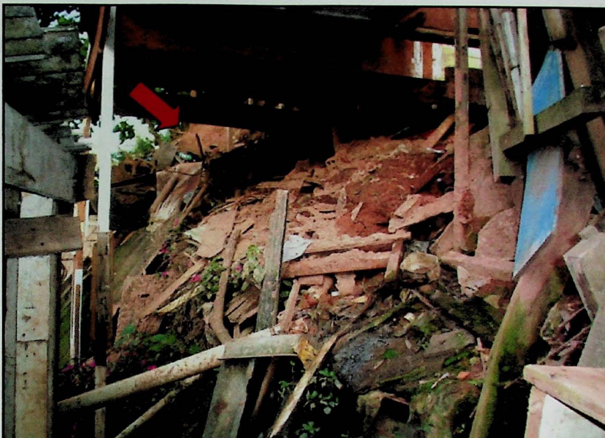
Foto 8 - Moradia apresentando o aterro utilizado em sua construção já escorregado. Observa-se que este aterro não apresentava nenhum tipo de compactação
