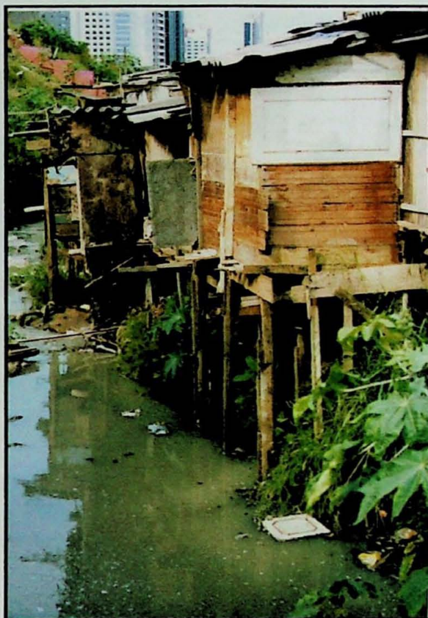
FC-RP-03c. Vista em detalhe das moradias às margens do córrego Real Parque. Há problemas com solapamento, principalmente nas moradias que se encontram nas curvas do córrego.
