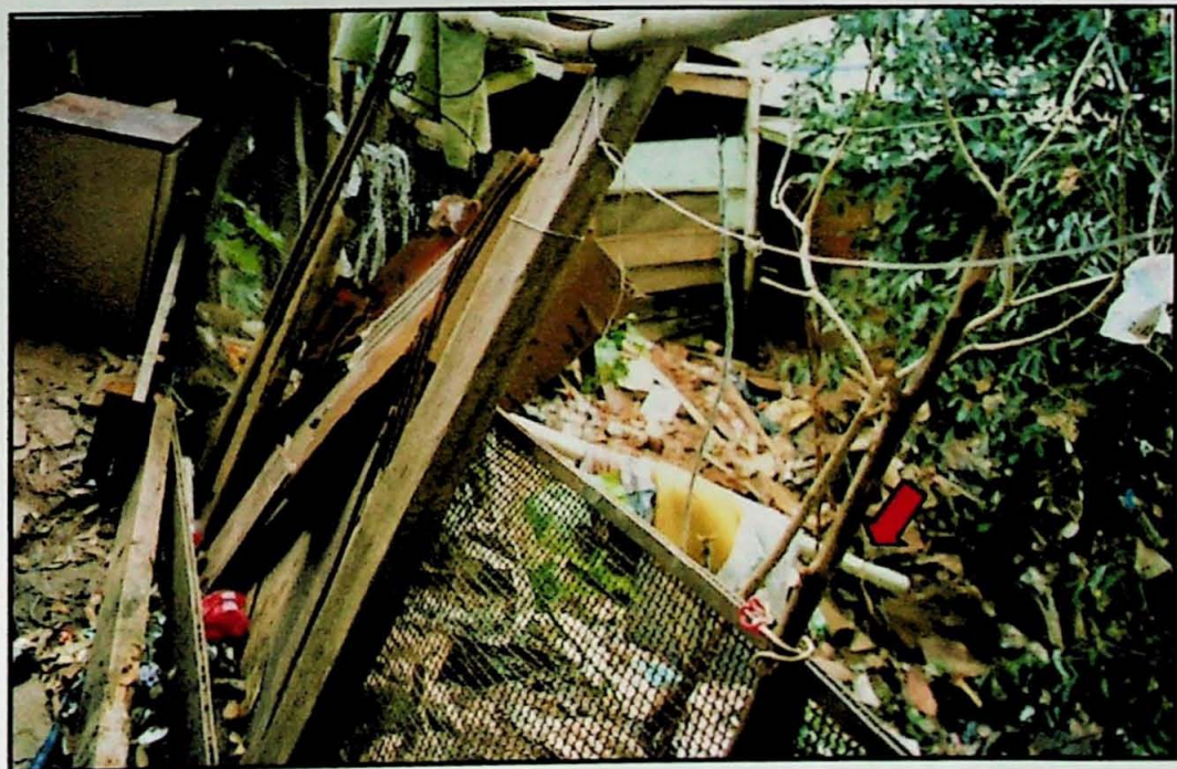
FC-RP-23a. Vista do topo do talude no ponto 1; observar a grande quantidade de lixo e entulho lançados, e a localização das moradias próximas ao topo do talude. Todas as moradias desta área lançam seu esgoto no próprio talude.
