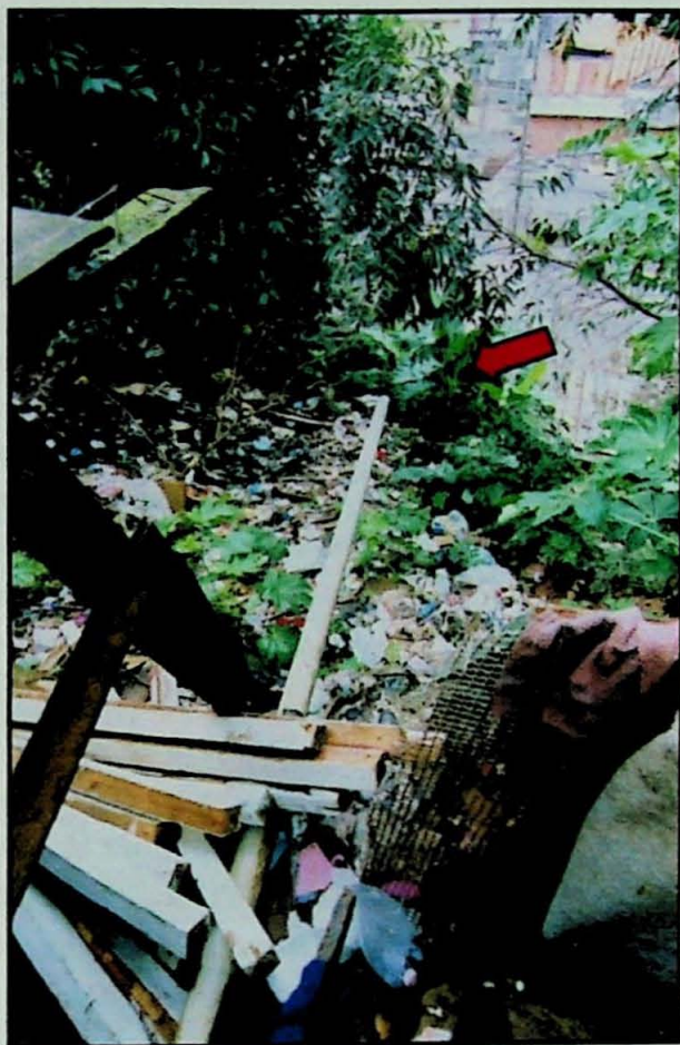
FC-RP-23b. Vista em detalhe da grande quantidade de lixo e entulho lançados na superfície do talude. O esgoto também é lançado talude abaixo.
