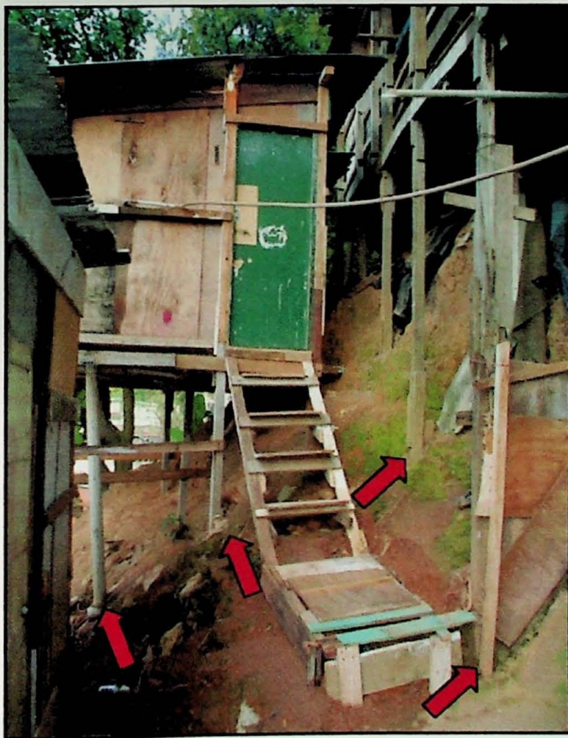
Foto 12 – Moradias praticamente penduradas na face do talude. Neste tipo de moradia, não há corte, o alicerce é cravado diretamente na superfície do talude.
