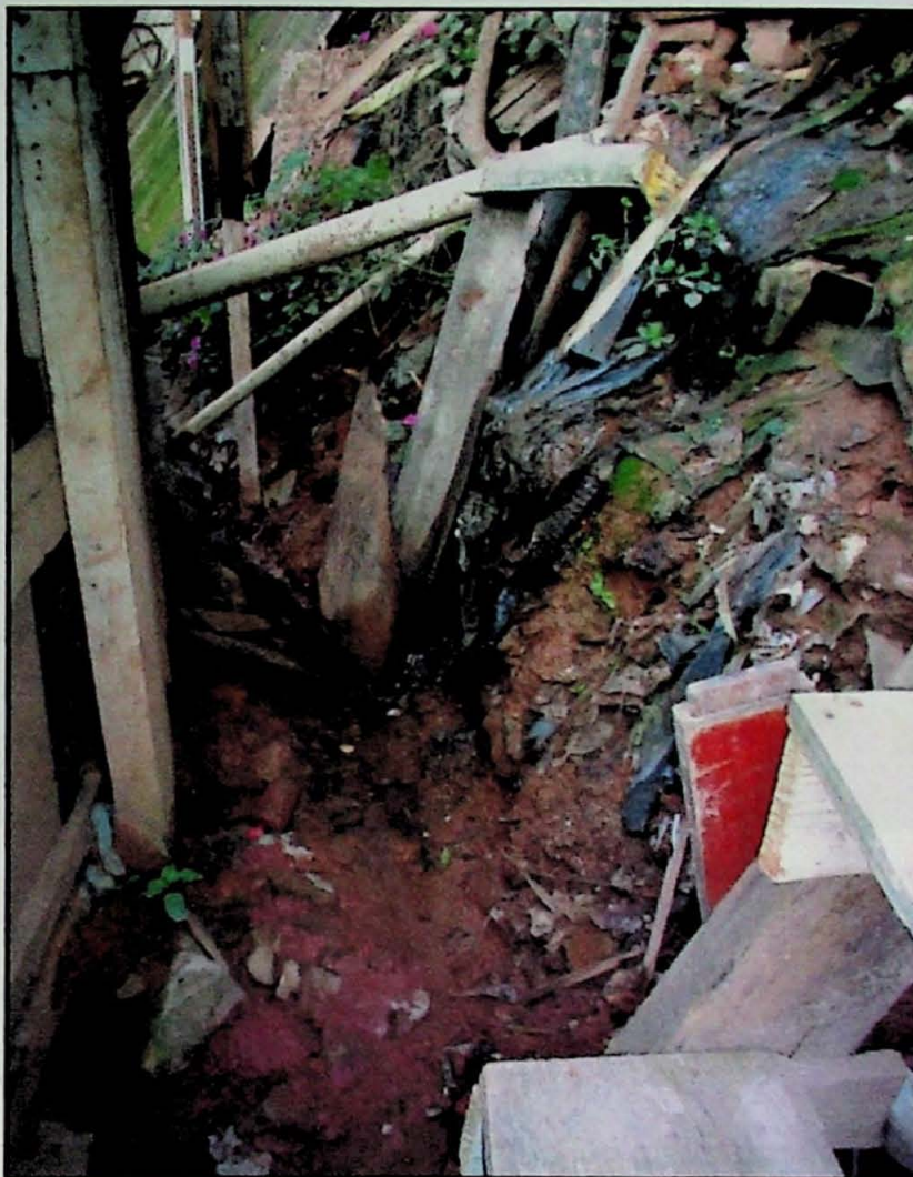
Foto 9 – Observa-se o acúmulo de água de chuva em superfície e o esgoto lançado a céu aberto, na parte de trás de uma moradia, o que origina verdadeiros canais no terreno.
