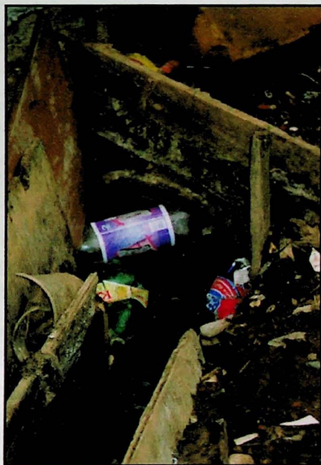
FC-RP-04a. Vista em detalhe do canal coletor, que já se encontra parcialmente obstruído pelo lixo que os próprios moradores jogam na viela. Observa-se um grande carregamento de sedimentos e sulcos de erosão na viela.
