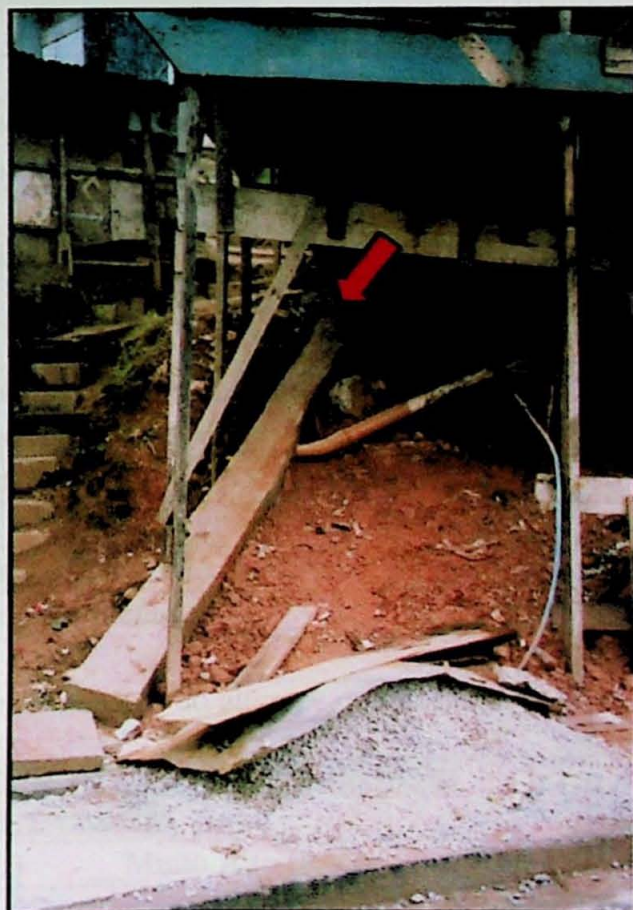
FC-RP-09a. Vista em detalhe da rede de esgoto que está sendo construída, para que seja evitado o lançamento do esgoto diretamente na superfície do talude de corte.
