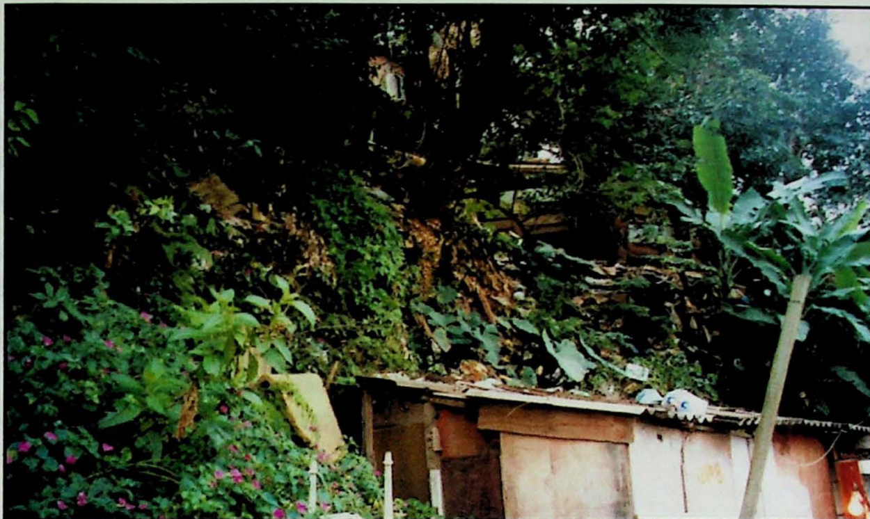
Foto 3 – Vista em detalhe da lateral direita do talude de corte com altura de 10 m, onde se observa um pequeno escorregamento atrás da moradia, no qual já se verifica um embarrigamento da parede junto ao talude.
