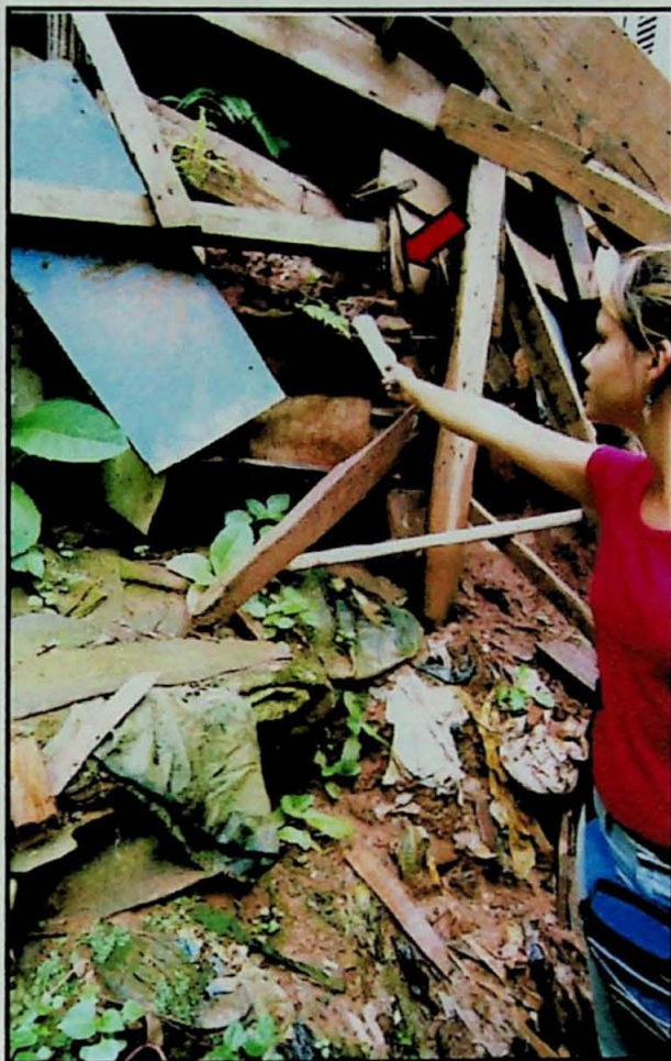
FC-RP-15. Vista em detalhe de uma das moradias que se encontra construída sobre o talude do ponto 1. Nesta foto, tirada um mês antes da realização das investigações geológico-geotécnicas, pode-se observar que parte do talude que sustenta a moradia encontra-se escorado por caibros e sarrafos de madeira, para evitar um possível escorregamento. No meio do talude há uma surgência de esgoto.
