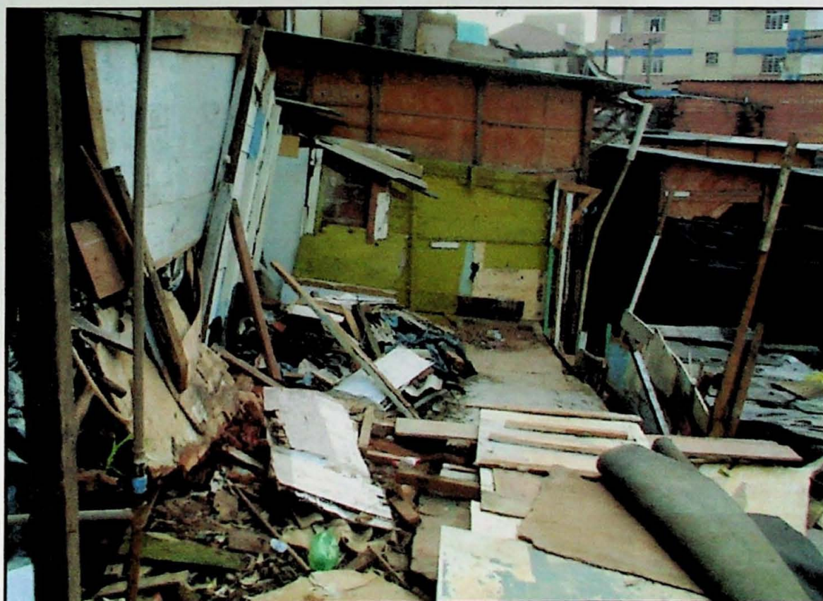
Foto 18 - Escorregamento de médio porte, deflagrado pela presença de um grande vazamento de esgoto gerado por um tubo rompido, o qual destruiu as duas moradias observadas na foto.
