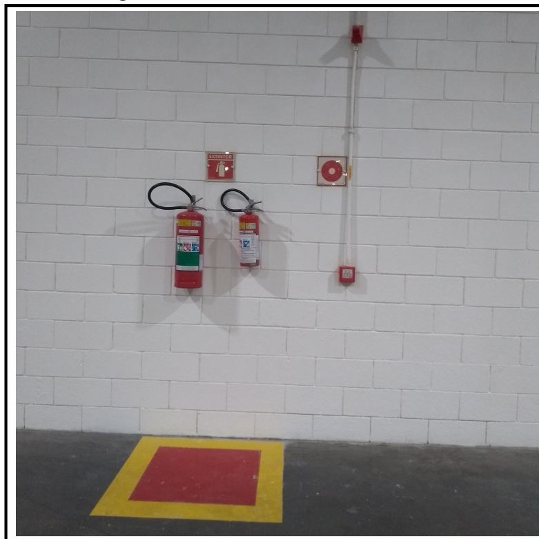
Figura 37 – Extintores de incêndio - Térreo
