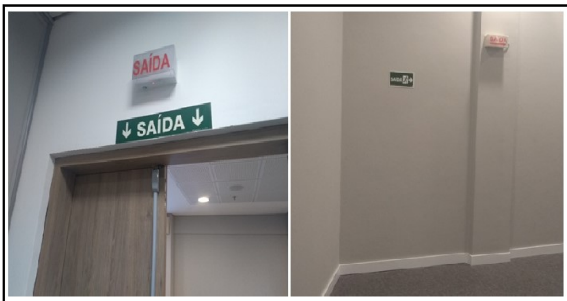
Figura 30 - Iluminação de emergência - Mezanino
