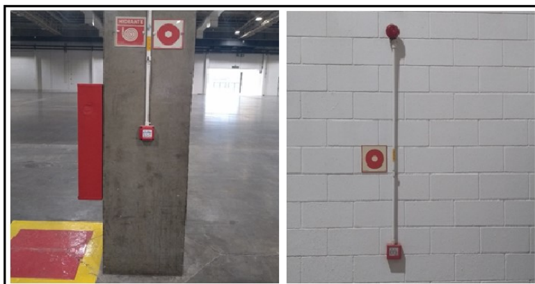
Figura 32 – Sinalização de Emergência Alarme de Incêndio
