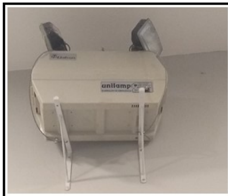
Figura 31 – Iluminação de Emergência nas escadas
