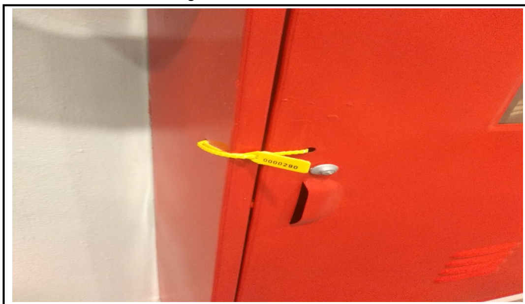
Figura 39 – Hidrante Obstruído
