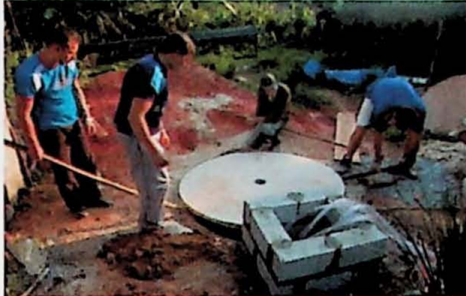
Figura 6.15 Fossa com tampa de concreto e respiro
