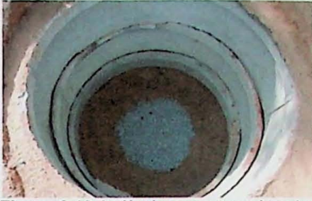
Figura 6.13 Anéis de concreto colocados
