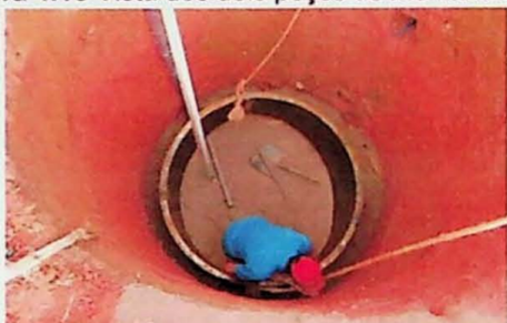
Figura 4.15 Acomodação do anel-guia para separação entre brita 1 externa ao anel e o material interno
