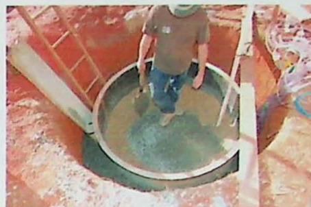
Figura 4.24 Início da camada 6, com disposição de pedrisco na borda interna do anel para direcionamento do fluxo do efluente
