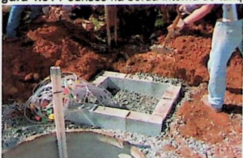
Figura 4.33 Caixa de concreto para acomodação das mangueiras
