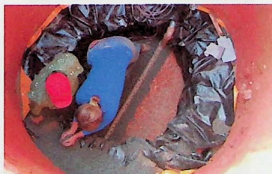
Figura 4.7 Cobertura do anel de concreto com vinilona
