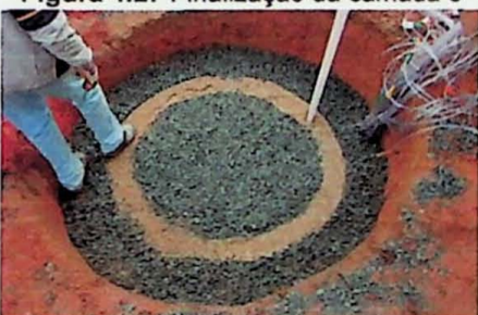
Figura 4.29 Vista do preenchimento e das mangueiras amostradoras
