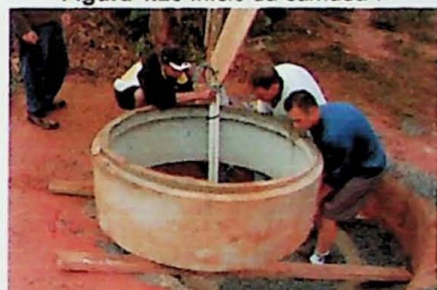
Figura 4.30 Anel de concreto (tanque) sendo colocado
