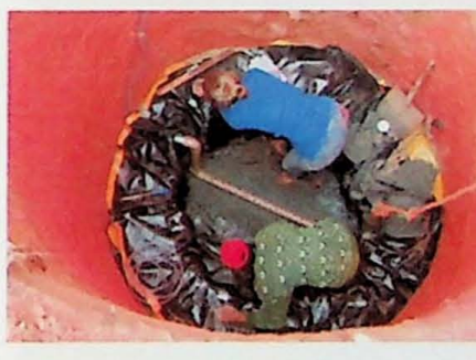
Figura 4.8 Fixação do dreno interno ao anel e conexões com o tubo vertical
