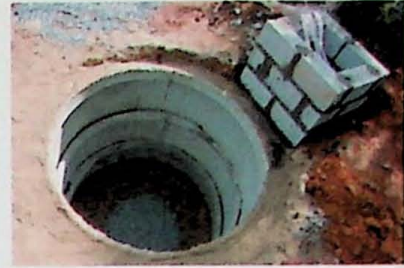
Figura 6.14 Vista da fossa e da caixa de concreto com as mangueiras amostradoras
