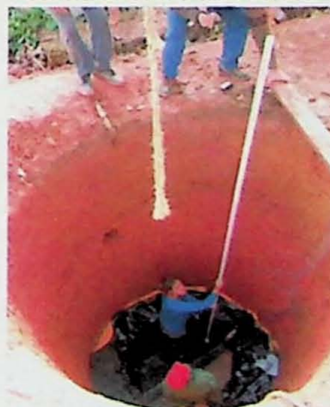
Figura 4.10 Posicionamento do poço de monitoramento a 4,2m (nivelado ao dreno)
