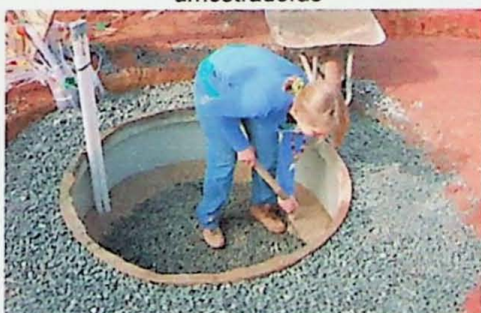
Figura 4.31 Pedrisco na borda interna do tanque
