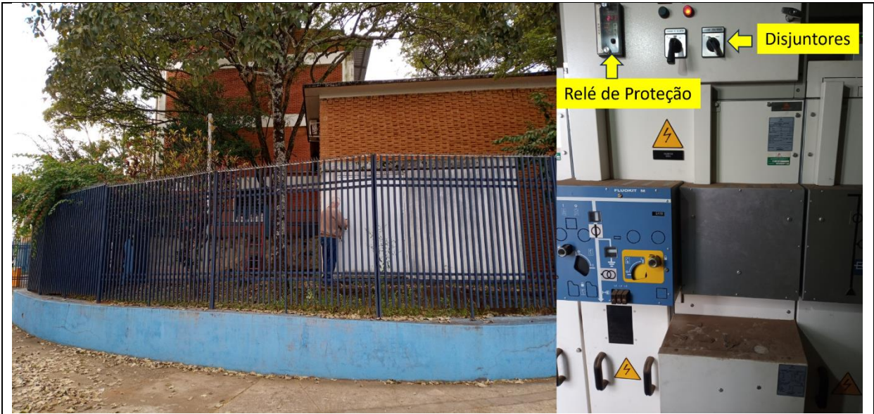
Figura 4: Vista da unidade consumidora Área Sul
