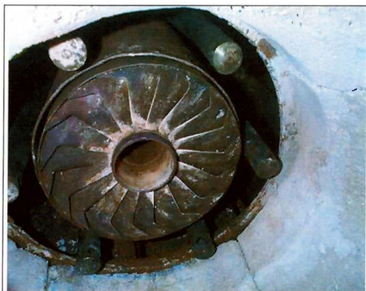
Figura 22 – Maçarico da Caldeira
