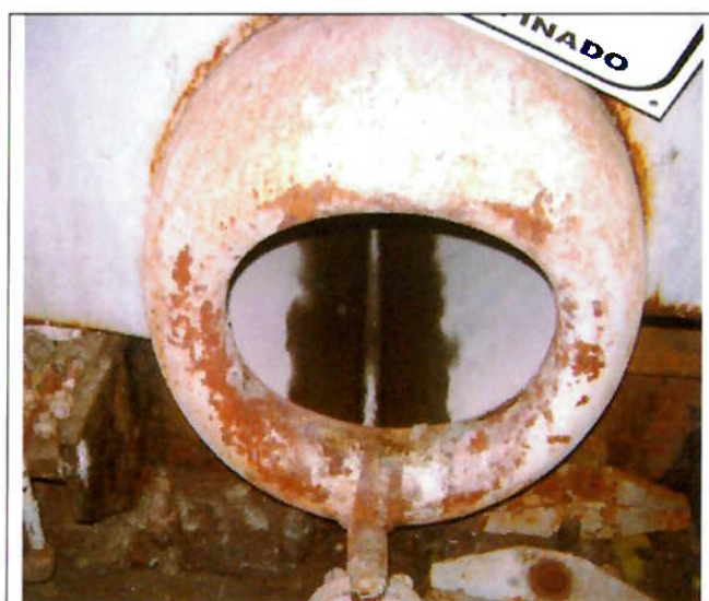
Figura 29 – Vista externa do tubulão inferior, entrada
